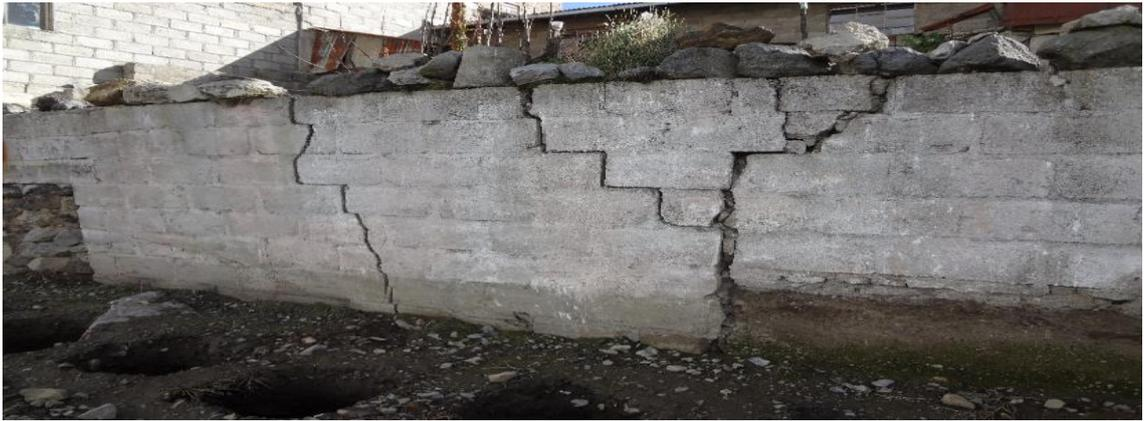
Figura 21. Muro sobre suelo arcilloso – Sector Patarcocha
