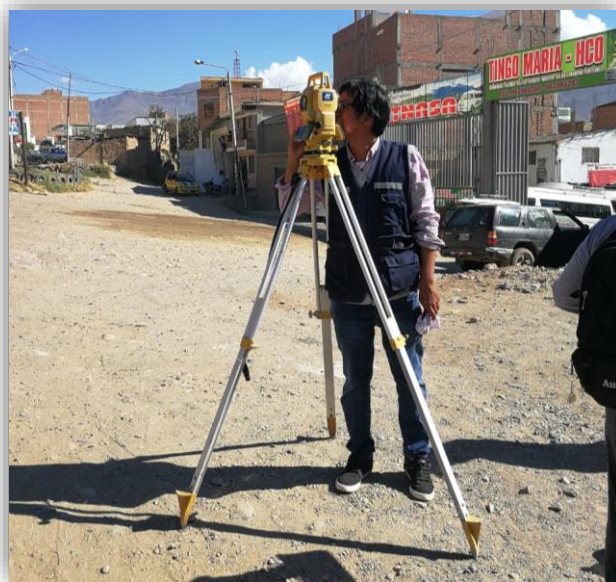
Figura N°22. Empleo de estación total. Fuente: Elaboración propia.
