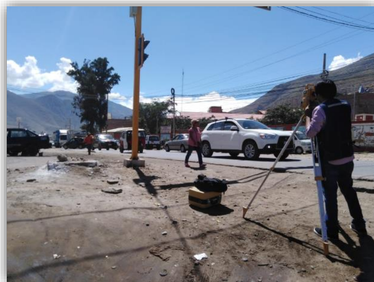
Figura N°15. Estación total Utilizada para el levantamiento topográfico. Fuente: Elaboración propia.
