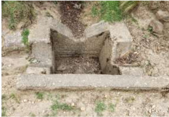
Alcantarilla 27 Progresiva: 15+530 km, falta de mantenimiento.
