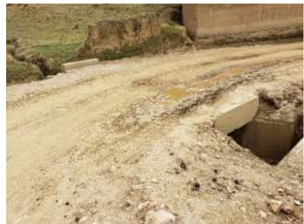
Alcantarilla 15 Progresiva: 11+009 km, falta de mantenimiento.
