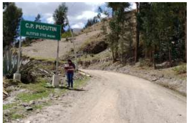
Señalización Informativa 3 en buenas condiciones.
