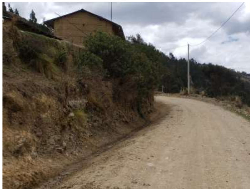
Figura 17. Cunetas en buen estado, debido al reciente mantenimiento realizado
