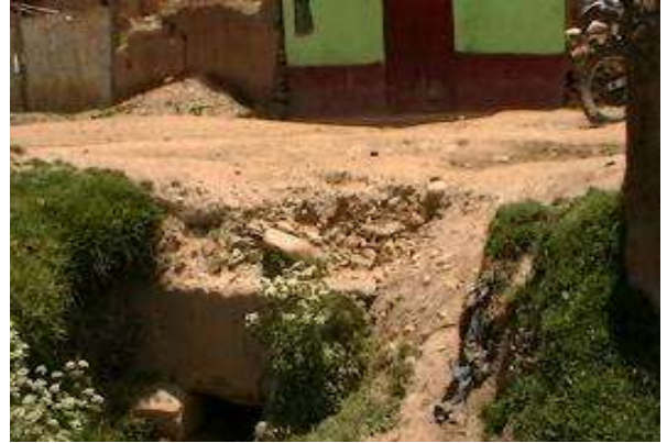
Alcantarilla 18 Progresiva: 12+161 km, falta de mantenimiento.
