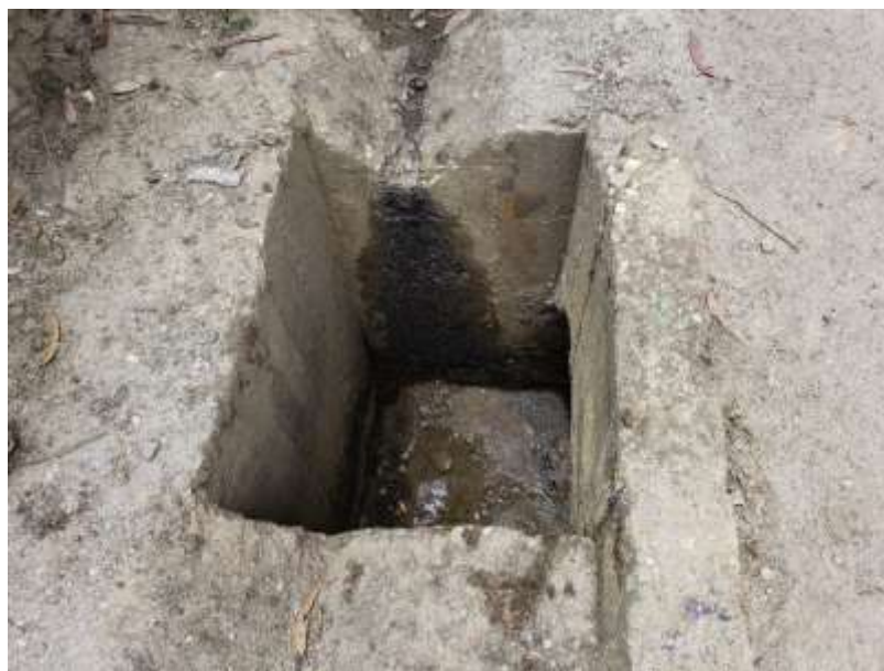
Figura 14. Alcantarilla de concreto en buenas condiciones
