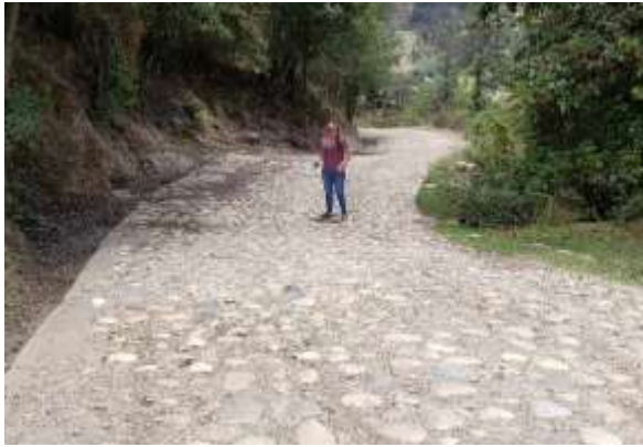
Baden 7 Progresiva 14+672 km, en buenas condiciones.
