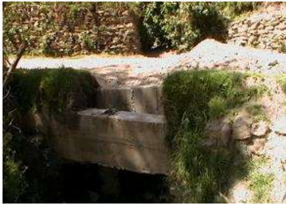
Alcantarilla 1 Progresiva: 2+737 km, falta de mantenimiento.
