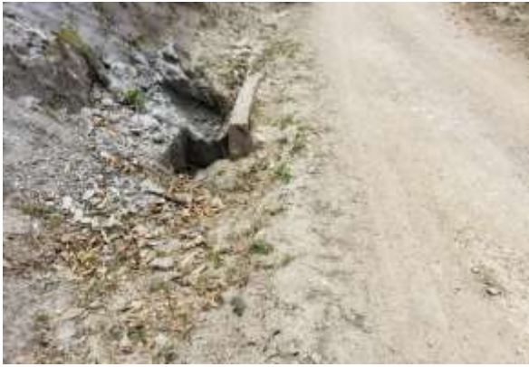
Alcantarilla 5 Progresiva: 6+561 km, falta de limpieza.
