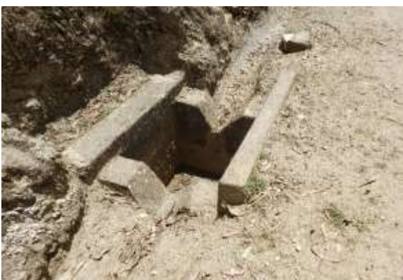
Alcantarilla 21 Progresiva: 14+071 km, en buenas condiciones.
