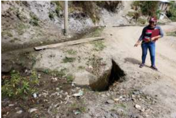
Alcantarilla 1 Progresiva: 2+737 km, falta de mantenimiento.
