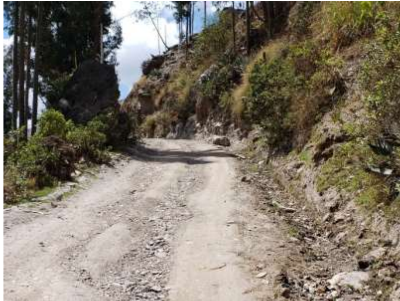
Figura 11. Erosión de nivel 1 en un tramo del camino vecinal FUENTE: Fotografía Propia
