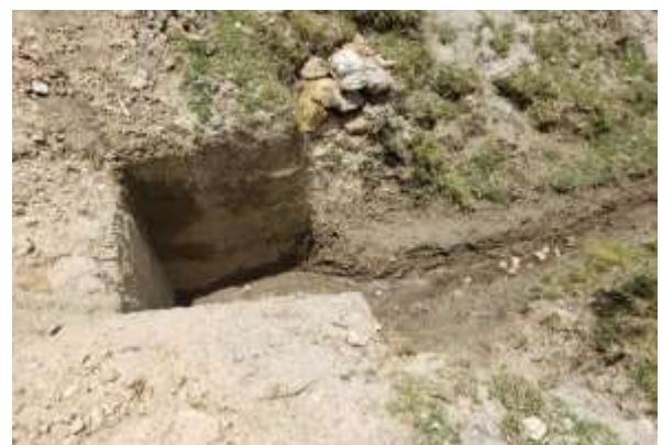
Alcantarilla 11 Progresiva: 9+835 km, falta de mantenimiento.
