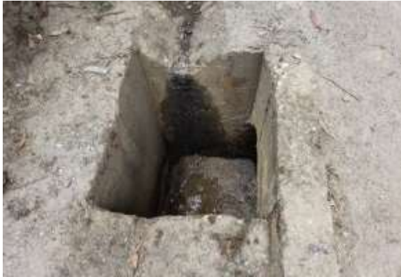
Alcantarilla 9 Progresiva: 8+658 km, en buenas condiciones.
