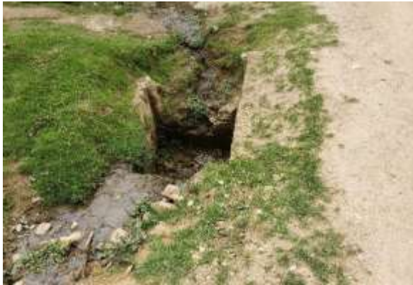
Alcantarilla 17 Progresiva: 12+050 km, falta de mantenimiento.
