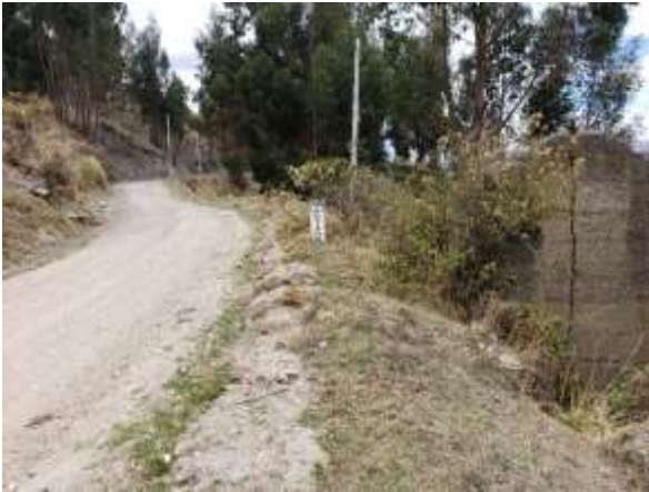
Alcantarilla 5 Progresiva: 6+561 km, falta de limpieza.
