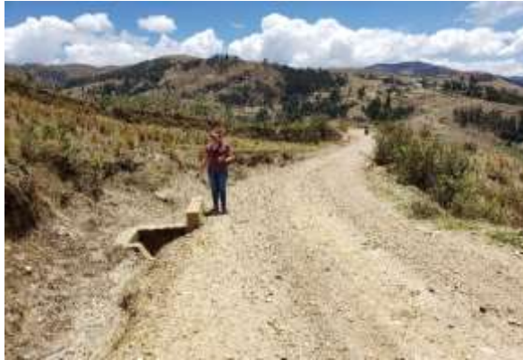
Alcantarilla 22 Progresiva: 14+357 km, en buenas condiciones.
