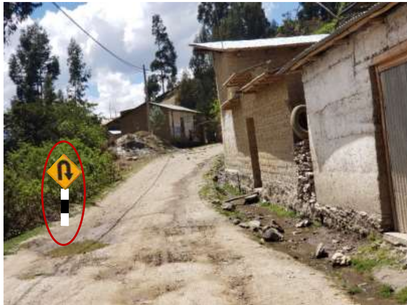
Figura 21. Falta de señalización preventiva en la entrada de una curva en U
