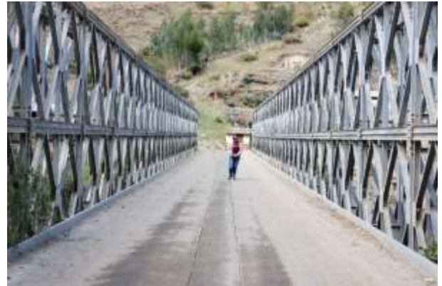
EMP. PE Puente Quipas. Progresiva: 0+000 - 0+059.86 km . Estado Bueno L=54.86 Metros
