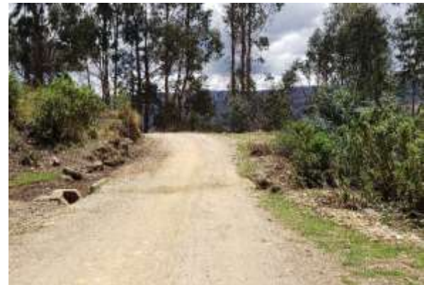
Alcantarilla 20 Progresiva: 13+827 km, en buenas condiciones.
