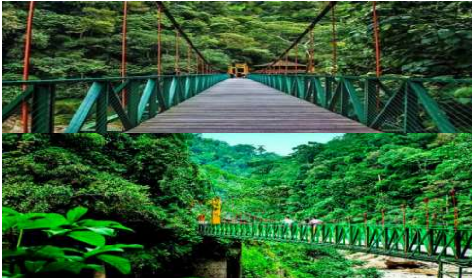
Figura 13: Vistas parciales del puente para llegar al mirador principal.
