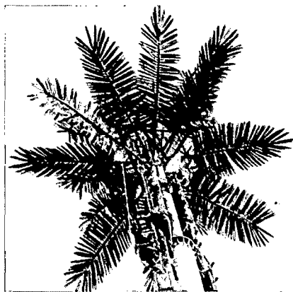
Figura N° 2.21.- Mimetizados de torre monopolo tipo árbol de palmera.
