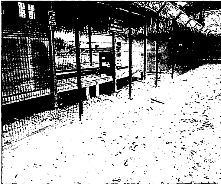
Figura N° B.13- Dado de concreto a nivel de terreno natural, postes metálicos de cerco.
