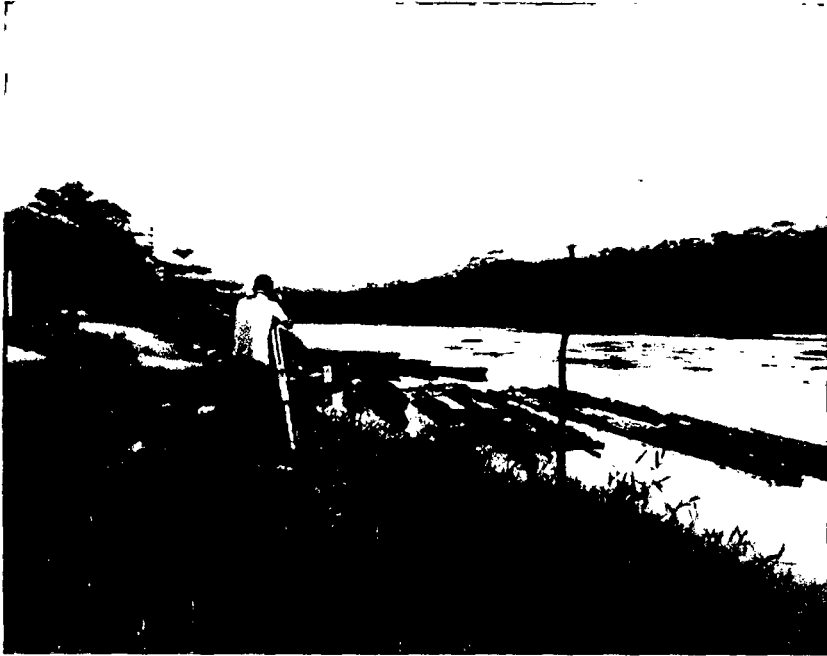
Foto N°09: Instalación del teodolito (estación 01).
