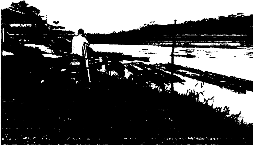
Foto N°09: Instalación del teodolito (estación 01).
