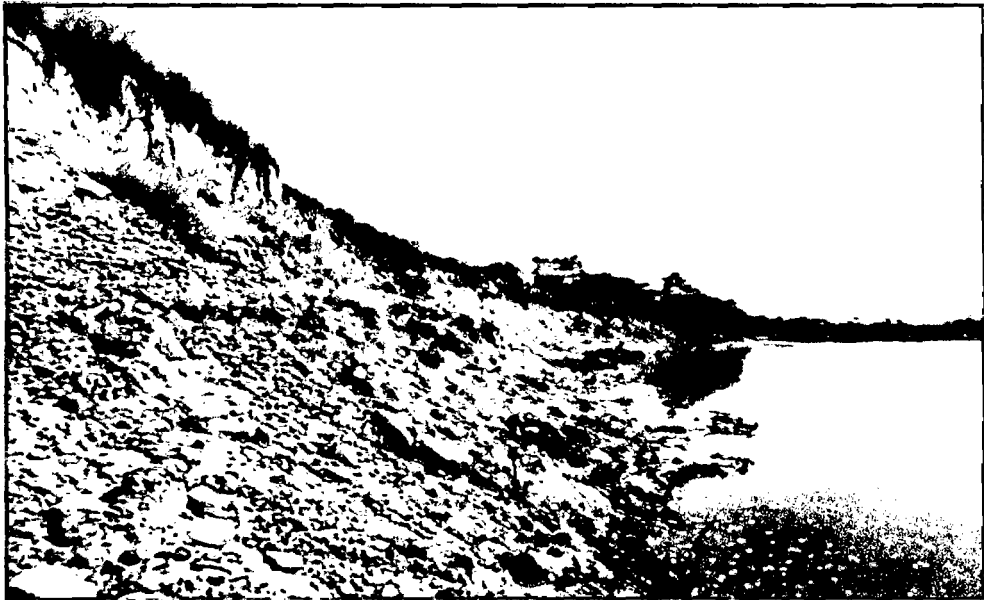
Foto N°17: Vista panorámica del rio Aguaytia en la margen derecha véase la amplitud de la sección del rio y la erosión en la margen derecha.
