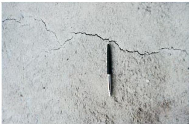
*Figura 11:* Las fisuras por contracción plástica se aparecen con rasgaduras en el concreto fresco (Kosmatka, y otros, 2004)
