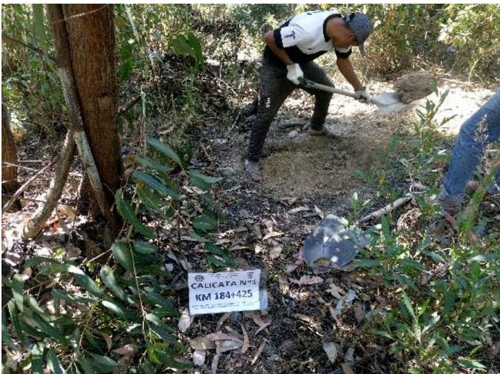
Figura N°63 Excavación de la Calicata N°1 Km 184+425
