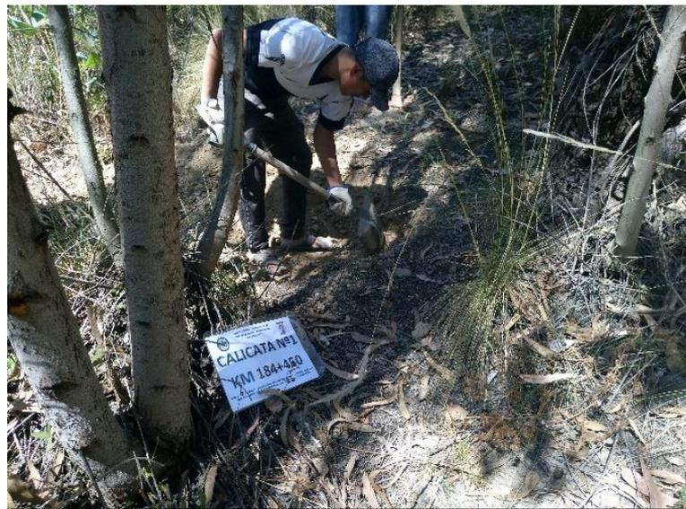
Figura N°66 Excavación de la Calicata N°1 Km 184+450
