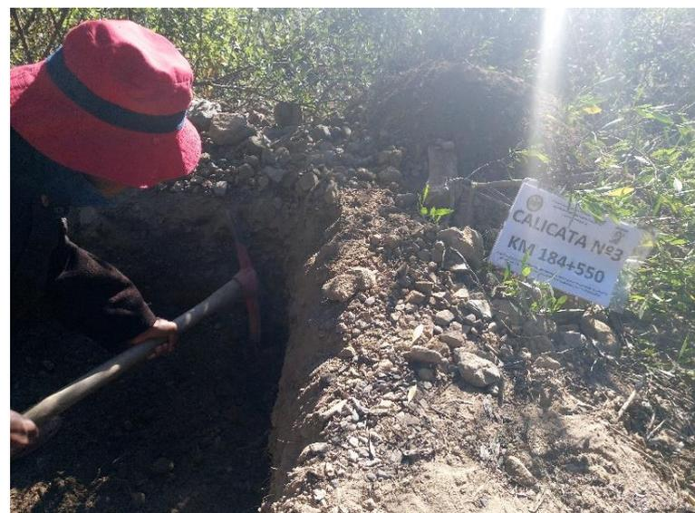
Figura N°73 Excavación de la Calicata N°2 Km 184+550
