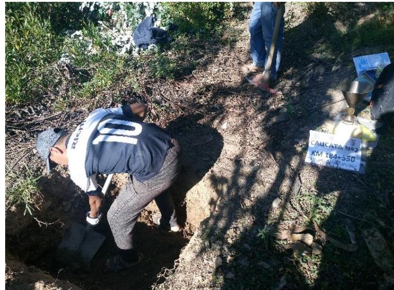
Figura N°74 Excavación de la Calicata N°3 Km 184+550
