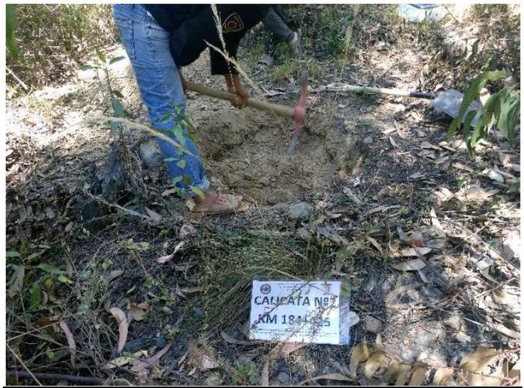
Figura N°64 Excavación de la Calicata N°2 Km 184+425
