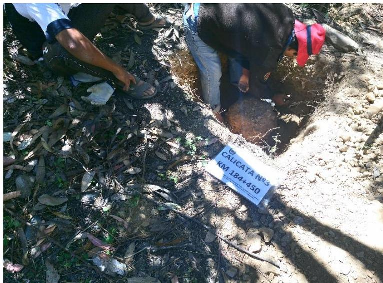
Figura N°68 Excavación de la Calicata N°3 Km 184+450
