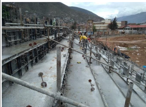
Fotografía N° 30: Ejecución del Vaciado, de Graderías en Tribuna Partida 05.01.03.03.10.
