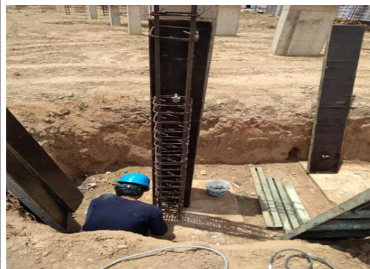
Foto N° 03: Ejecución de la Partida 05.01.03.03.05.02 Encofrado y Desencofrado Caravistas Columnas en el eje 36 - Sector Sur.
