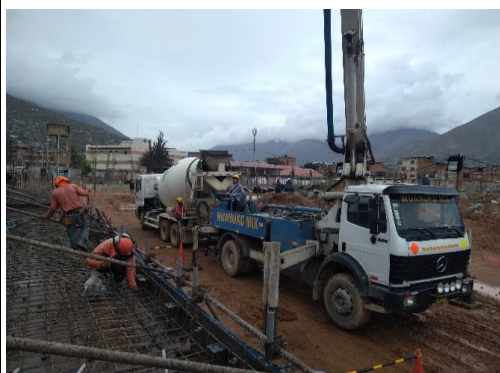
Fotografía N° 28: Ejecución del Vaciado, preparación de Losa Maciza de Graderías Partida 05.01.03.03.11.
