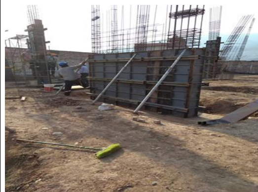
Foto N° 06: Ejecución de la Partida 05.01.03.03.12.02 Encofrado y Desencofrado Caravistas Placas en el 122 - Sector Occidente.
