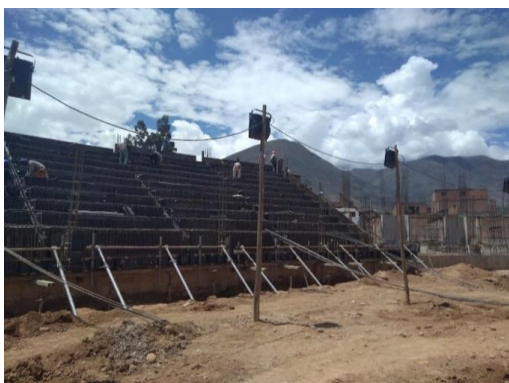
Fotografía N° 39: Ejecucion de la Partida de 05.01.03.03.10.02 Encofrado y Desenc. Caravista en Graderías de Tribuna Oriente Sector N° 13.
