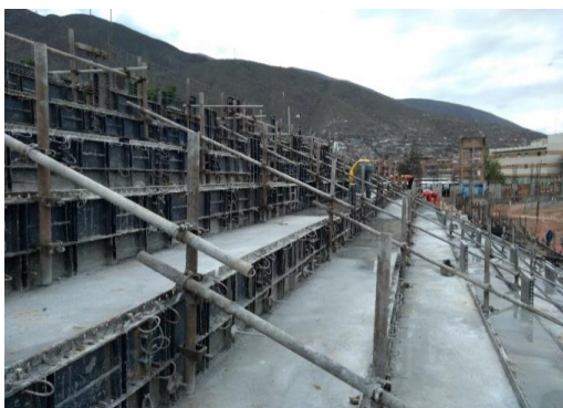
Fotografía N° 33: Ejecución de la Partida 05.01.03.03.10.02 Desencofrado en Graderías de Tribuna.
