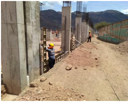
Foto N° 18: Ejecución de la Partida 05.01.03.03.03.03 Encofrado y Desencofrado en Cimieto Corrido - Sector Oriente.
