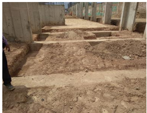
Foto N° 09: Se realiza la excavación del cimiento corrido - Sector Oriente
