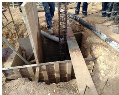
Foto N° 14: Se realiza la partida 05.01.03.03.01.01 Concreto para Zapatas F'c= 210 \text{ kg/cm}^2 en el Sector Sur.
