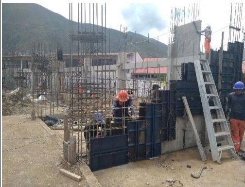
Foto N° 38: Ejecucion de Encofrado de Placa en Tribuna Sur.
