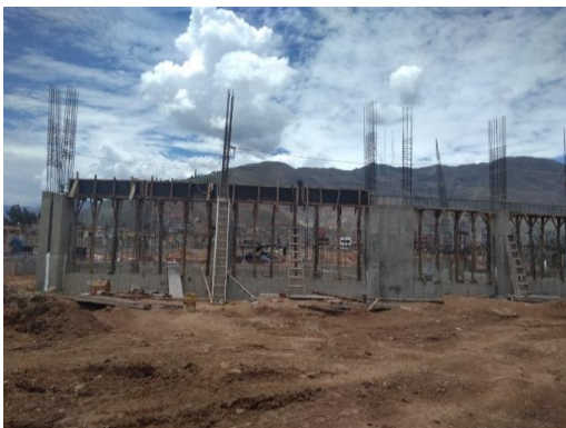
Fotografía N° 37: Ejecución de la Partida 05.01.03.03.08 Encofrado de Viga en Sector N° 10 Tribuna Sur.
