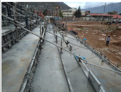
Foto N° 36: Vista de Tribuna Post Vaciado Sector N° 14 Oriente.
