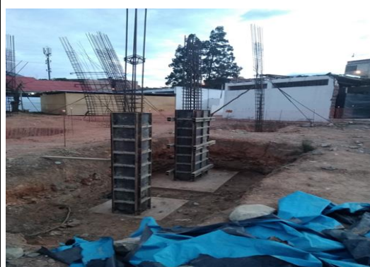
Foto N° 02: Ejecución de la Partida 05.01.03.03.05.02 Encofrado y Desencofrado Caravistas Columnas en el eje 32 - Sector Sur.
