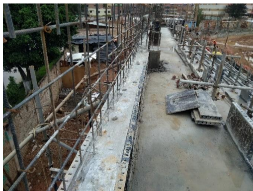
Fotografía N° 35: Desencofrado de Graderías de Tribuna.
