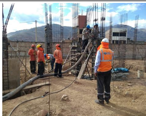
Foto N° 11: Ejecución de la Partida 05.01.03.03.05.01 Concreto para Columnas F'c= 210 kg/cm 2 en el eje 118 - Sector Occidente.
