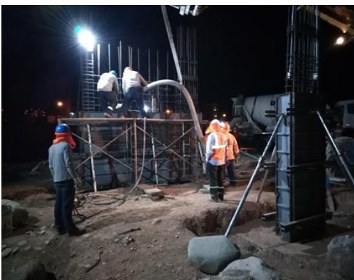
Foto N° 15: Ejecución de la Partida 05.01.03.03.12.01 Concreto para Placas F'c= 210 \text{ kg/cm}^2 - Sector Occidente.
