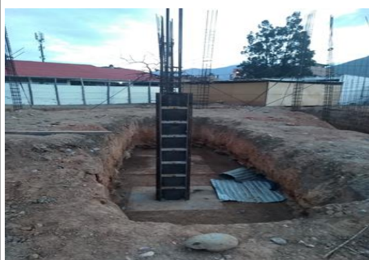
Foto N° 01: Ejecución de la Partida 02.07.02.01.04.03.02 Encofrado y Desencofrado Normal en Columnas en el eje 35 - Sector Sur.
