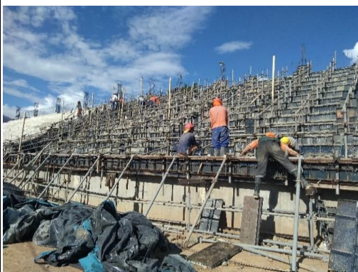
Foto N° 40: Ejecucion de la Partida de 05.01.03.03.10.01 Concreto Gradas FC=210 KG/CM2 de Tribuna Oriente Sector N° 13.
