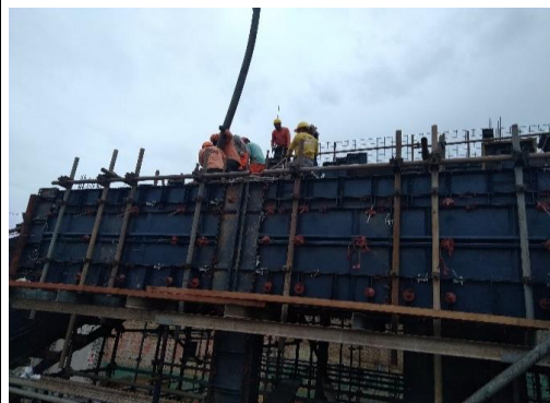
Fotografía N° 30: Ejecución del Vaciado, de Graderías en Tribuna Partida 05.01.03.03.10.
