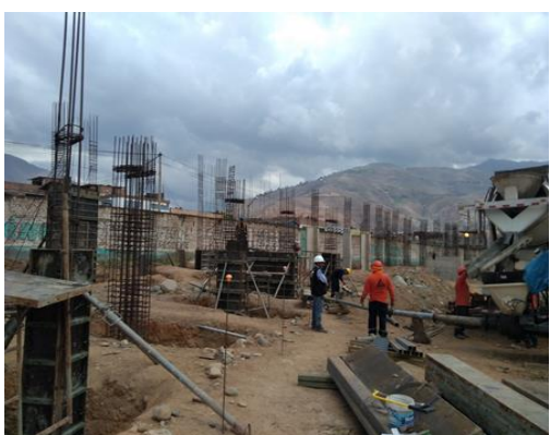
Foto N° 15: Ejecución de la Partida 05.01.03.03.12.01 Concreto para Placas F'c= 210 \text{ kg/cm}^2 - Sector Occidente.
