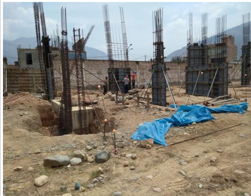
Foto N° 08: Ejecución de la Partida 05.01.03.03.12.02 Encofrado y Desencofrado Caravistas Placas - Sector Occidente.
