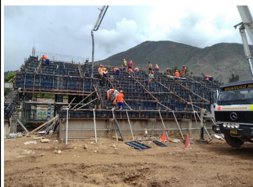
Fotografía N° 25: Ejecución de Pulido de la Tribuna Oriente Sector N° 14. ).
