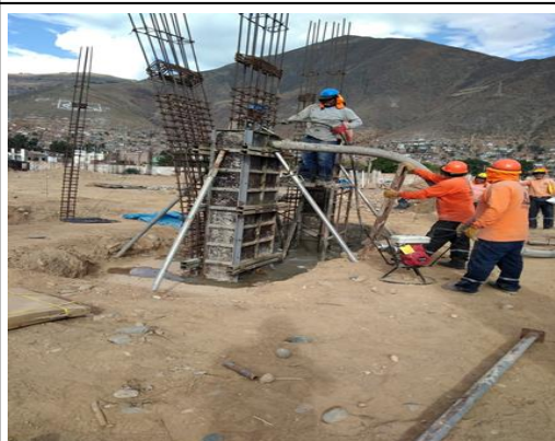
Foto N° 10: Ejecución de la Partida 05.01.03.03.12.02 Encofrado y Desencofrado Caravistas Placas eje 118 - Sector Norte.
