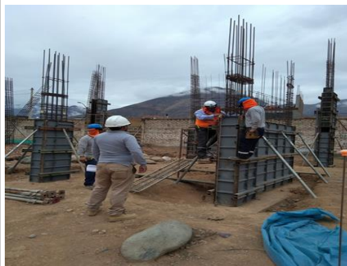
Foto N° 10: Ejecución de la Partida 05.01.03.03.12.02 Encofrado y Desencofrado Caravistas Placas eje 118 - Sector Norte.
