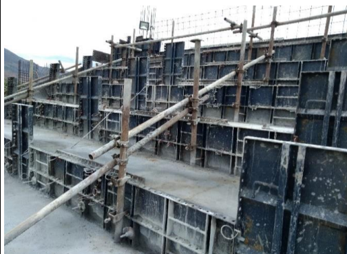
Foto N° 34: Vista de Tribuna Post Vaciado Sector N° 14 - Oriente.
