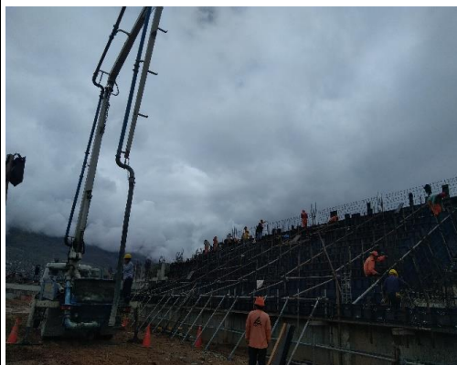
Fotografía N° 24: Estación y Nivelación del Camión Pluma en Obra.
