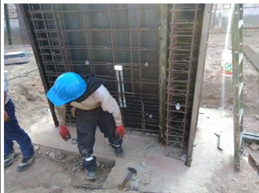
Foto N° 04: Ejecución de la Partida 05.01.03.03.12.02 Encofrado y Desencofrado Caravistas Placas en el eje 29 - Sector Sur.
