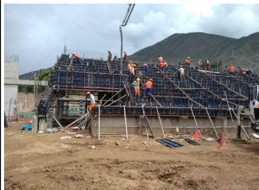
Fotografía N° 27: Ejecución de Pulido de la Tribuna Oriente Sector N° 14.
