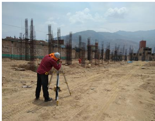
Foto N° 07: Se coloca las alturas del vaceado
