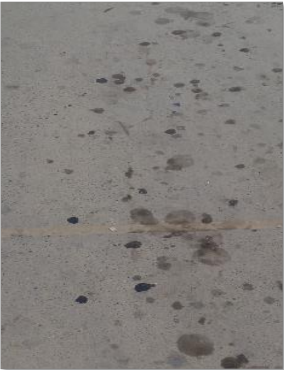
Figura 2: Descascaramiento de junta.
