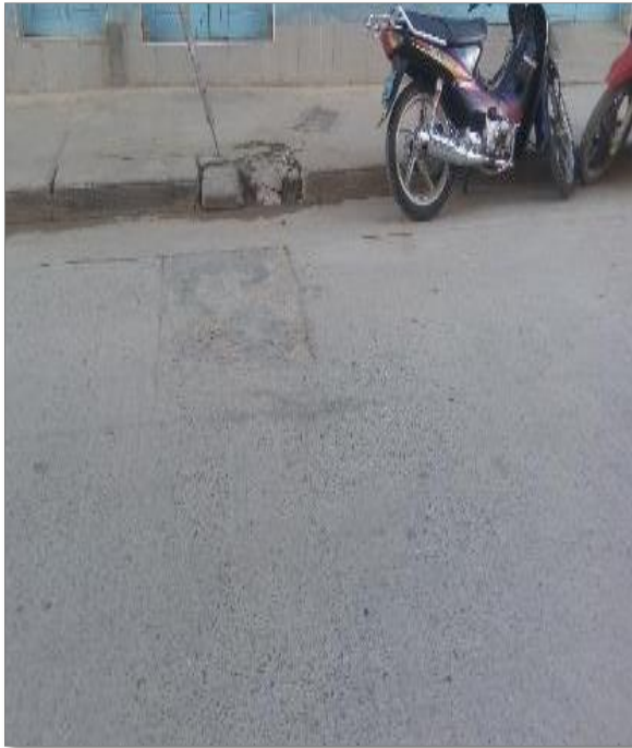
Figura 1: Parcheo y corte útil.
