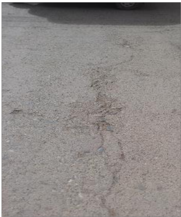
Figura 3: fisura transversal.
