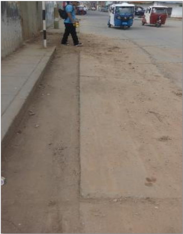
Figura 4: Grietas lineales.
