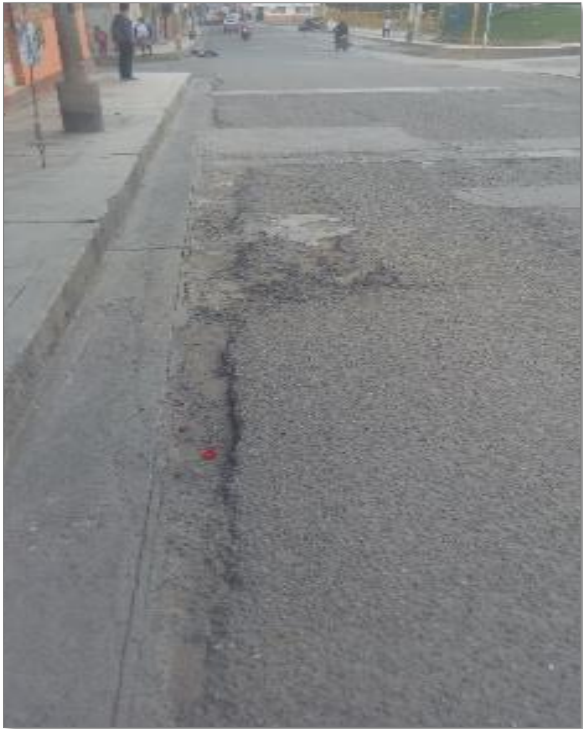
Figura 1: Ahuellamiento.
