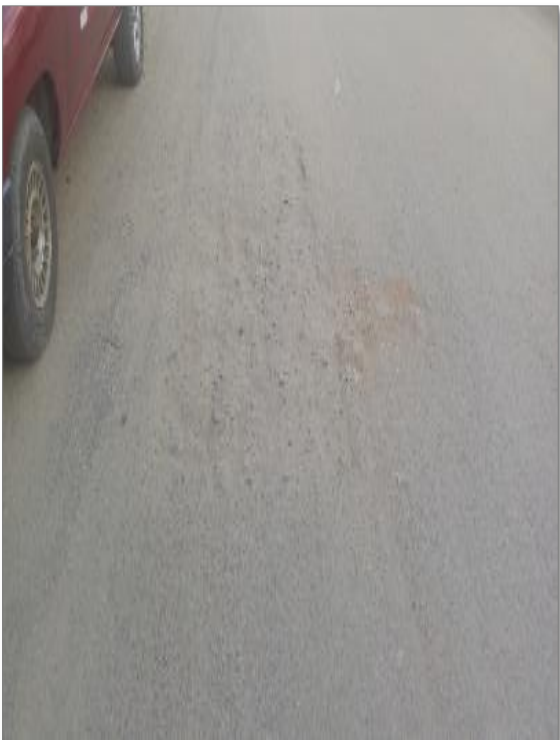
Figura 2: Agregado pulido.
