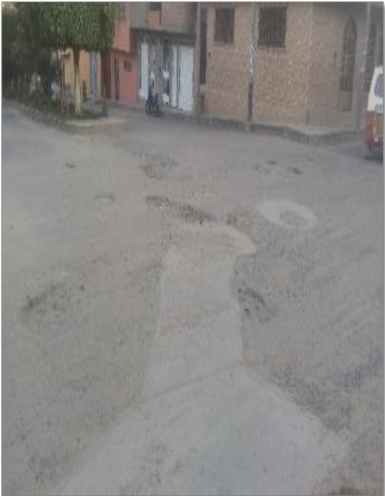
Figura 1: Parcheo y corte útil.
