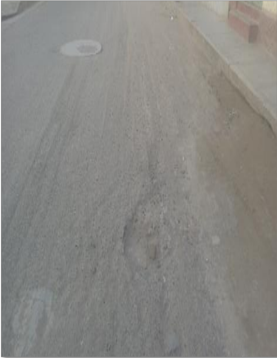
Figura 2: Agregado pulido.
