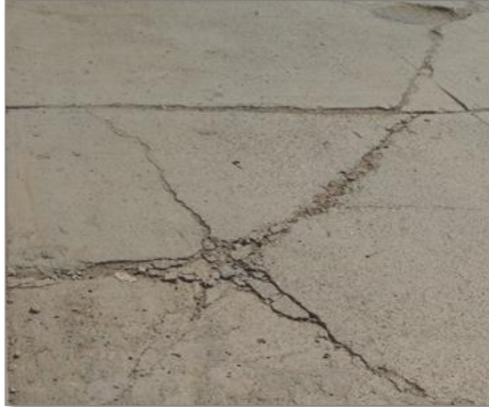
Figura N° 12: Fallas de Punch-out en pavimentos rígidos.
