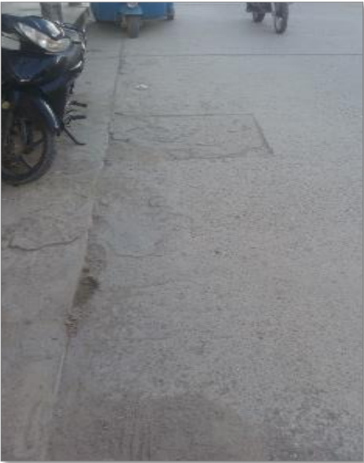
Figura 2: Parcheo y corte útil.
