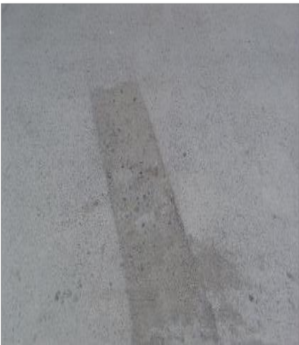
Figura 2: Parcheo y corte útil.
