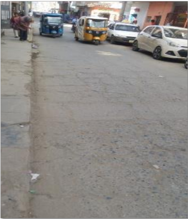
Figura 2: Fisura en bloque.
