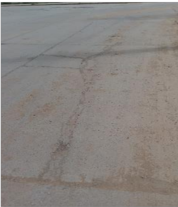
Figura 2: Fisura longitudinal.
