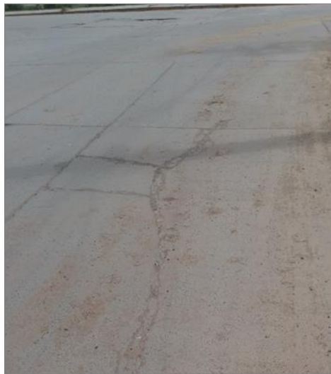
Figura N° 14: Cracking lineal.
