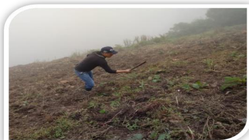
01. Limpieza de terreno
