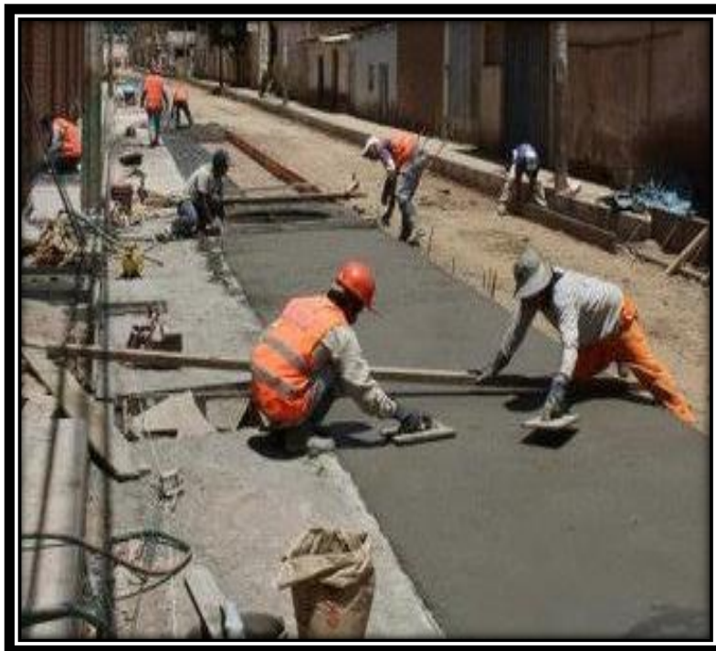
LA EJECUCION DE PISTAS Y VEREDAS
