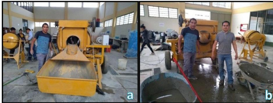
Figura 2-8 Mezclado del concreto (a) mezcladora de 11p3, (b) finalización de los trabajos de preparación del concreto.
