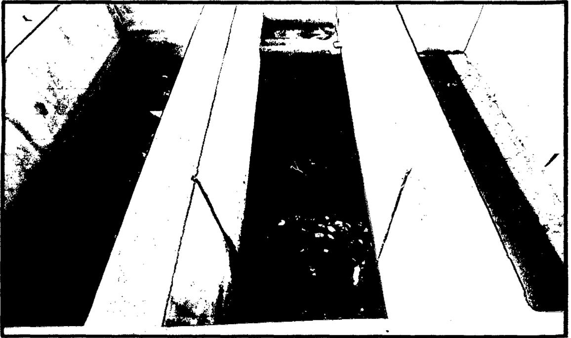
Fotos N° 88, 89, 90, 91, 92, 93 y 94. Filtro biológico (se nota que nunca entro en funcionamiento), lecho se secado de lodos convertido en laguna
