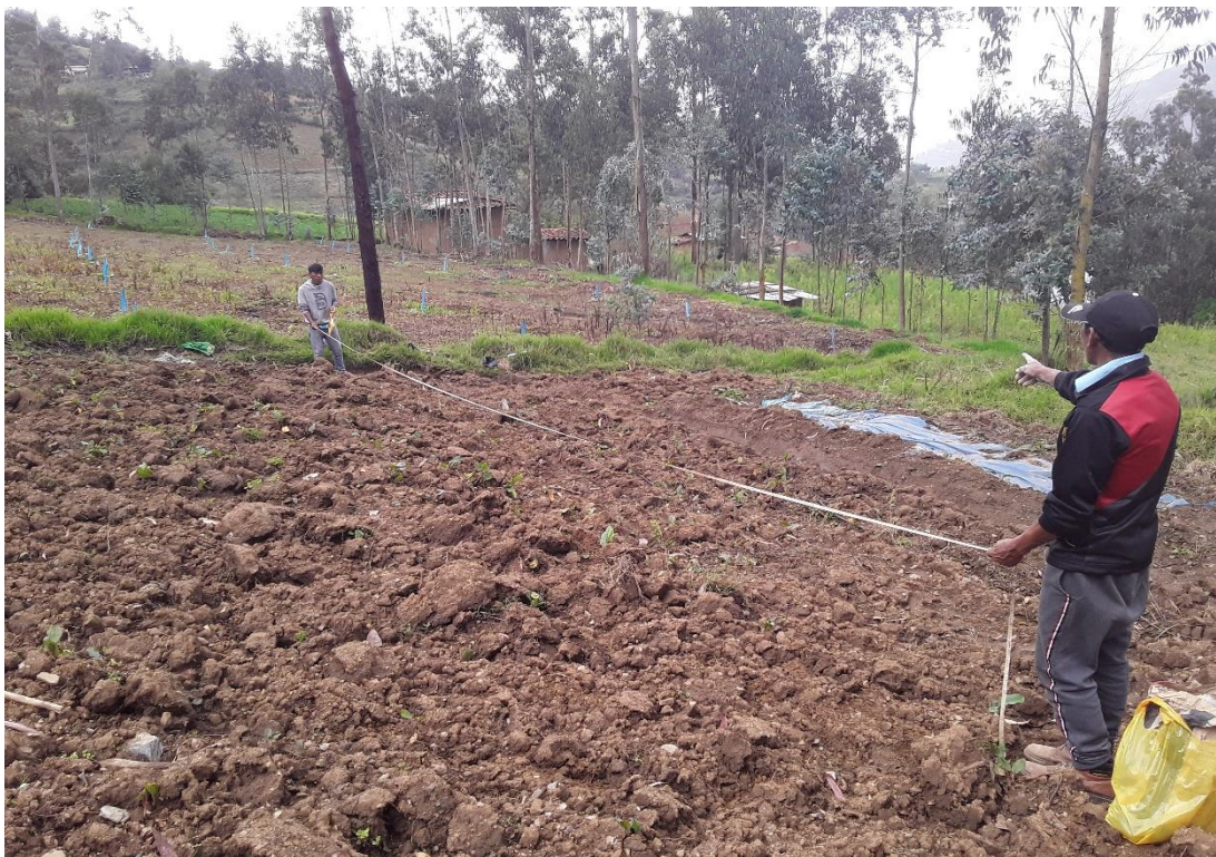
Figura 06. Medición y marcado de golpes en el terreno
