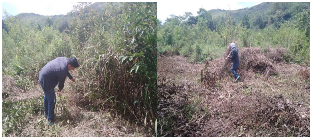
Fig. 01 Limpieza del terreno
