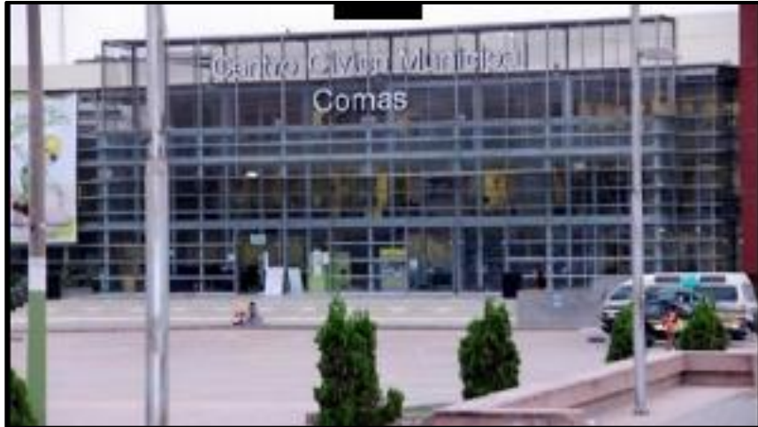
Figura 21. Fachada principal del Centro Cívico municipal de Comas
