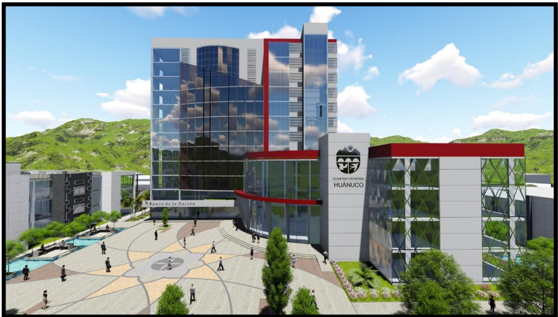
Figura 124. Vista Sede central Gobierno Regional Huánuco
