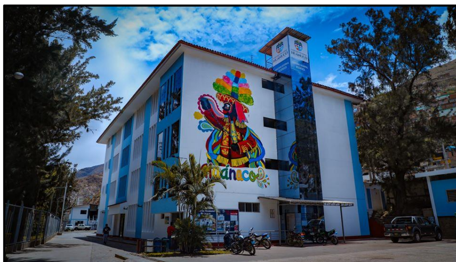
Figura 49. Vista del Módulo 2 Gobierno regional de Huánuco BLOQUE A.
