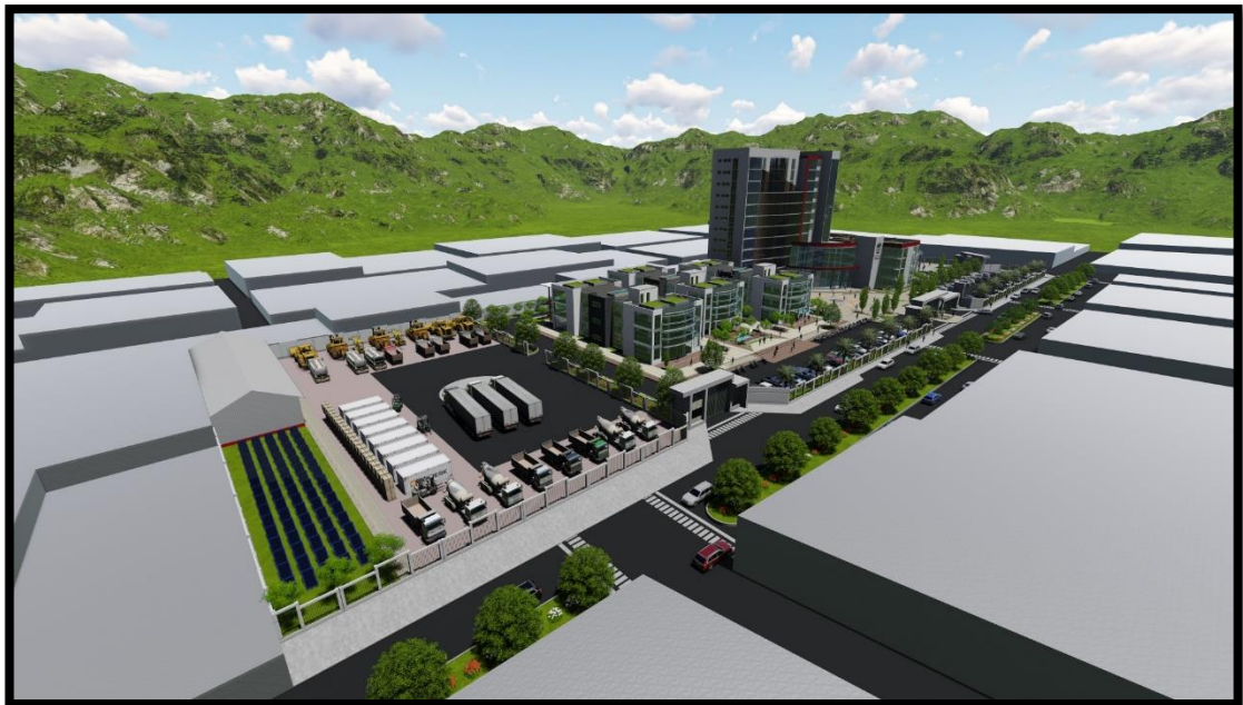
Figura 120. Vista panorámica del proyecto Gobierno regional Huánuco
