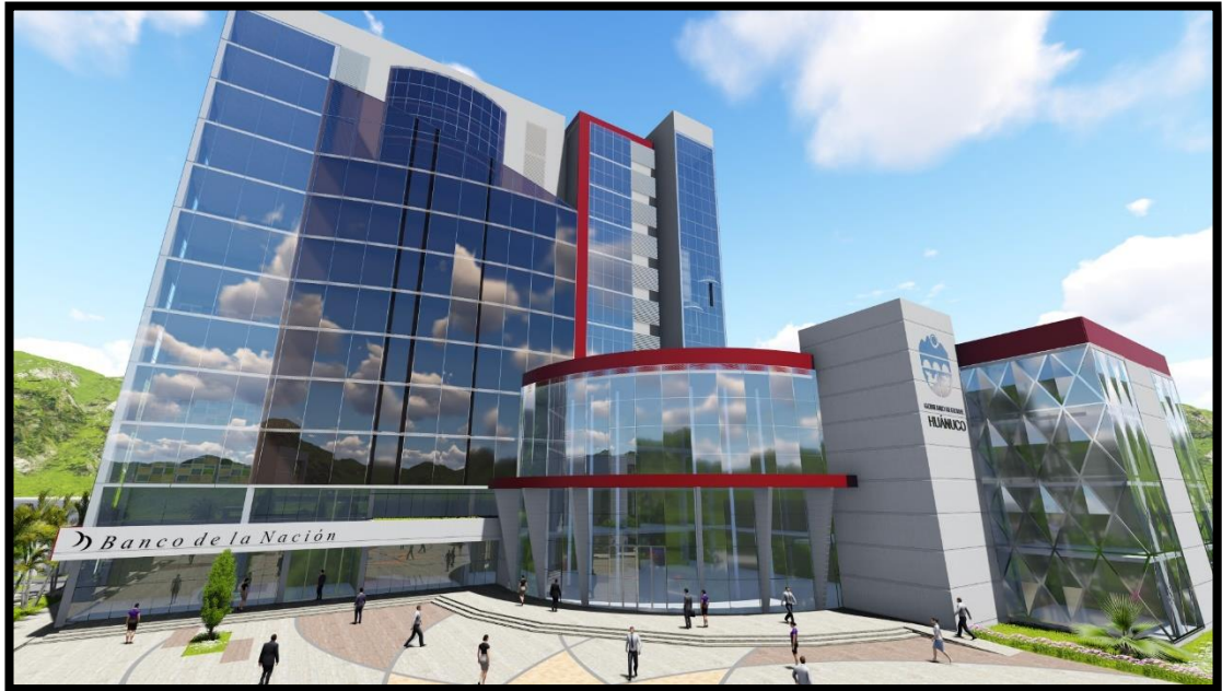
Figura 125. Vista Frontal Sede central Gobierno Regional Huánuco
