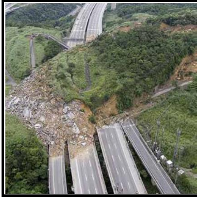
Ilustración N° 1: Deslizamiento de tierra sepulta parte de una autopista en Taiwan
