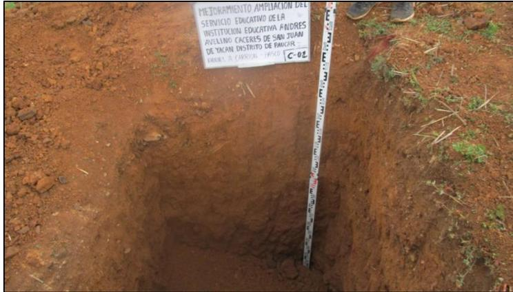
Ilustración N° 10: Excavación de la calicata N°02
