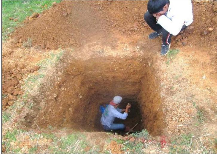
Ilustración N° 11: Excavación de la calicata N°03
