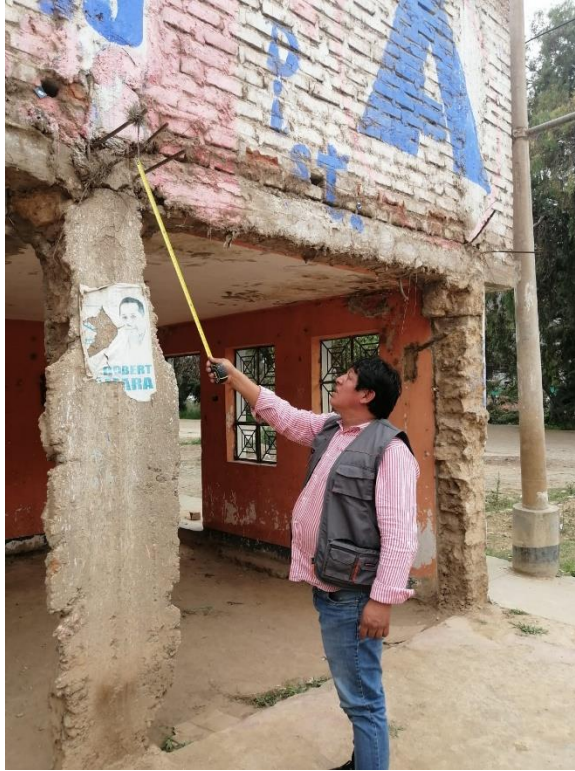
Imagen N° 5: Se visualiza la distribución de acero en vigas en viviendas autoconstruidas
