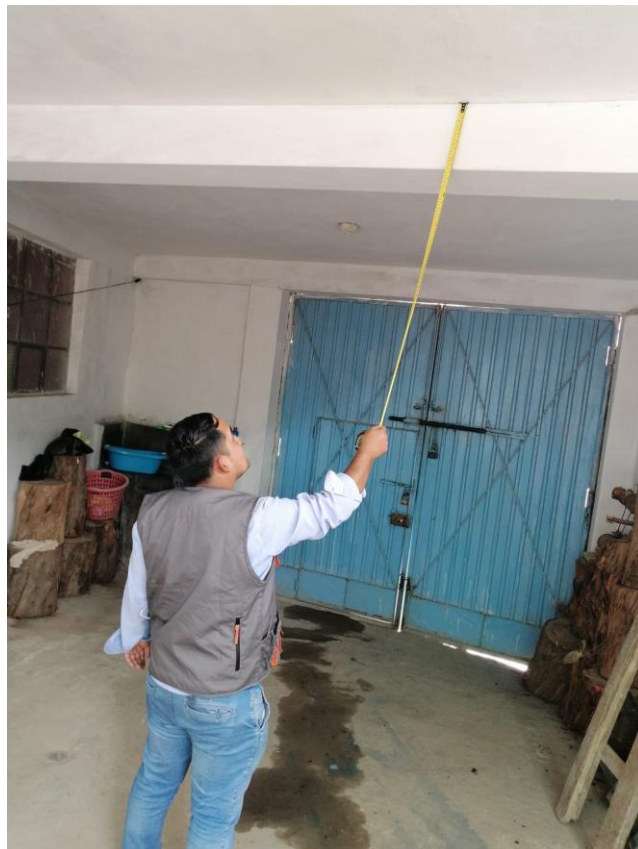
Imagen N° 6: Verificación de las dimensiones del peralte de vigas en viviendas autoconstruidas- segunda vivienda en estudio
