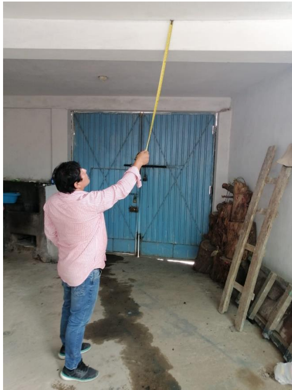
Imagen N° 7: Verificación de las dimensiones del peralte de vigas en viviendas autoconstruidas- segunda vivienda en estudio.
