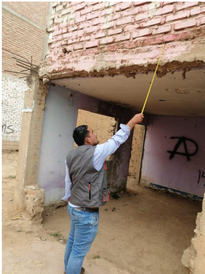
Imagen N° 4: verificación de las dimensiones del peralte de viga de la vivienda en estudio.
