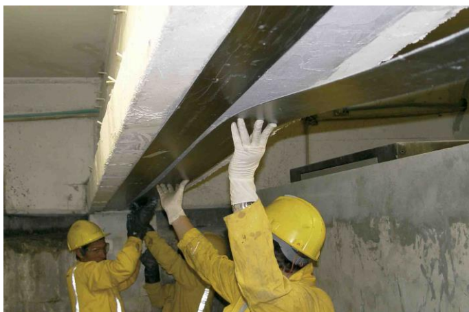
Figura 31: Colocación de refuerzo por flexión (fuente equipo técnico Sika Carbodour)
