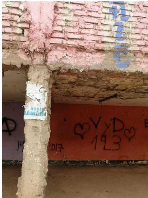
Imagen N° 2: Se visualiza la distribución de acero en vigas en viviendas autoconstruidas
