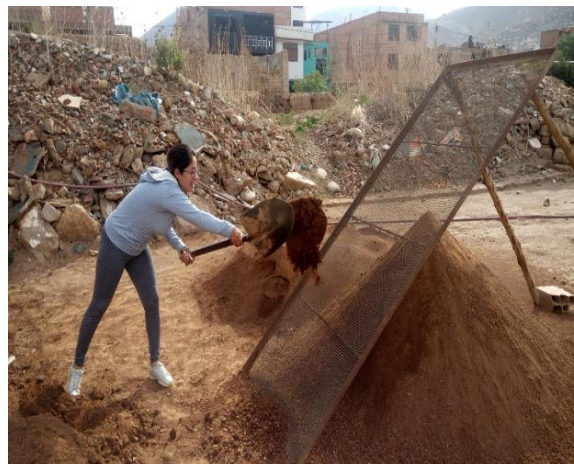
Figura 12. La fabricación del adobe, comenzó con el tamizado del suelo.
