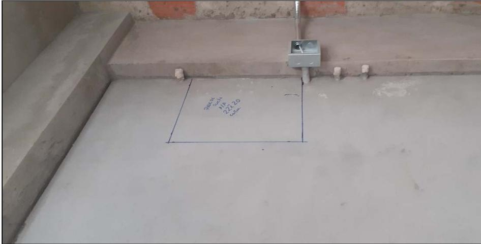
FOTO 01: Trazo para demolición de muro de albañilería en el nivel 1.
