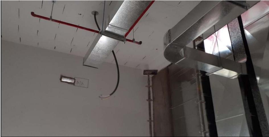
FOTO 02: Retrabajo de perforado de pases identificados a ultimo momento en el 5to nivel.
