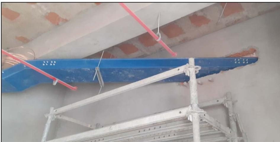
FOTO 03: Perforado para pase de bandeja electrica en el nivel 1.
