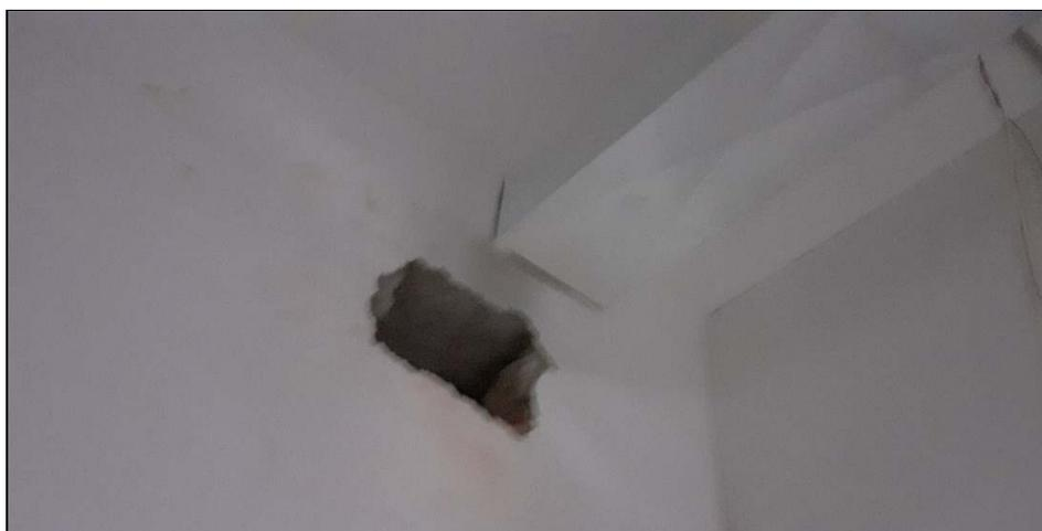
FOTO 03: Perforado para pase de aire acondicionado en el 5 nivel
