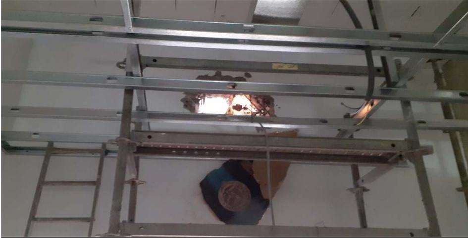
FOTO 01: Perforado de pase en muro de albañilería en el 5to nivel.
