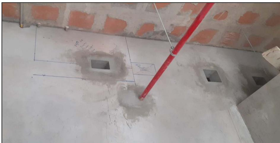
FOTO 01: Trazo para perforaciones de pases de Aire Acondicionado 5to nivel.
