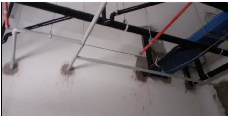
FOTO 02: Resane de pases de Bandejas eléctricas en el 5 Nivel.
