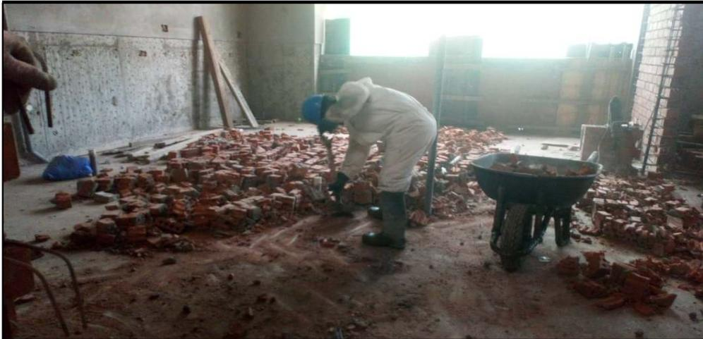
FOTO 01: Demolición de muro a causa de modificaciones en el 5to nivel.
