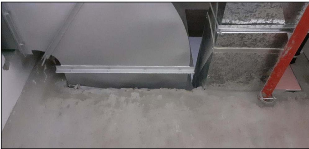
FOTO 02: Perforado de muro para pase de ducteria de Aire Acondicionado en el 5 Nivel.
