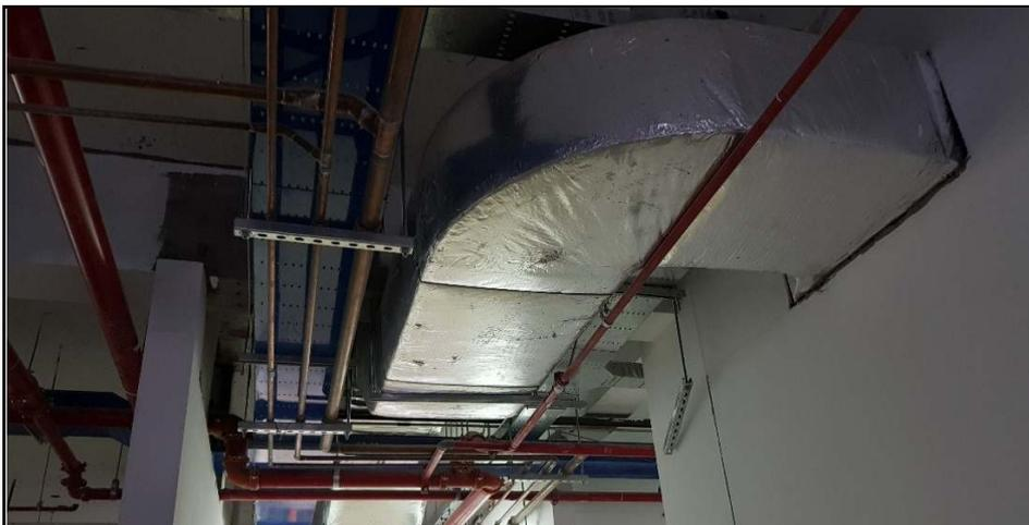
FOTO 03: Retrabajos de derrames en pases de ductos de Aire Acondicionado.
