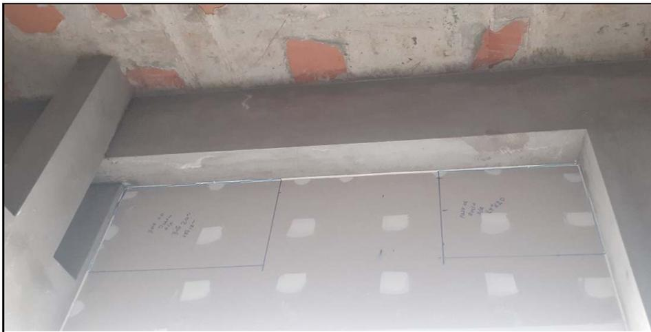
FOTO 02: Trazo para demolición de muro de drywall en el nivel 1.
