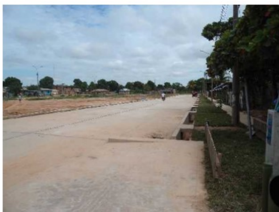
PAVIMENTACION DE LA CALLE SANTIAGO SABOYA – CUADRA 1 DISTRITO DE MANANTAY – CORONEL PORTILLO – UCAYALI – EN EJECUCION
