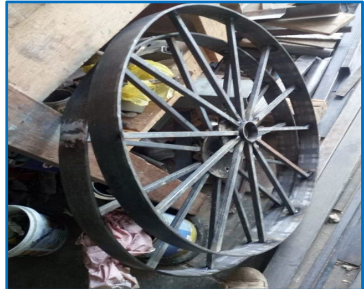
Figura 52 Ruedas habilitadas a la estructura.
