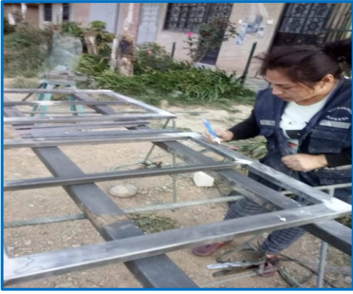
Figura 44 Partes laterales de la estructura
