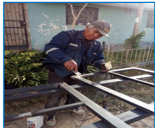
Figura 41 Masillando para reparar desperfectos (1)
