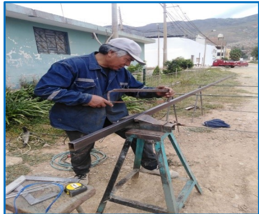
Figura 38 Proceso de corte para el armado de la estructura
