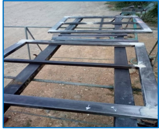
Figura 43 Masillando para arreglar desperfectos
