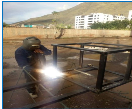
Figura 45 Unión de las partes de la estructura.
