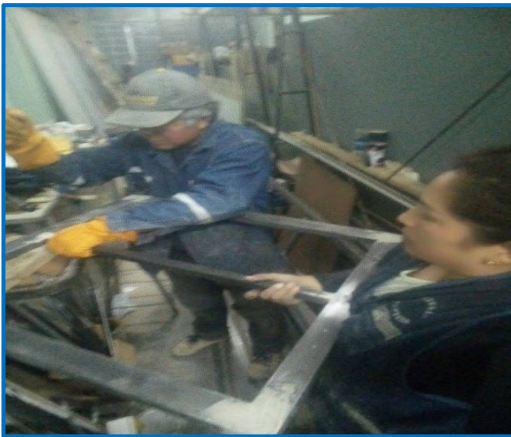
Figura 46 Perforación de los tubos
