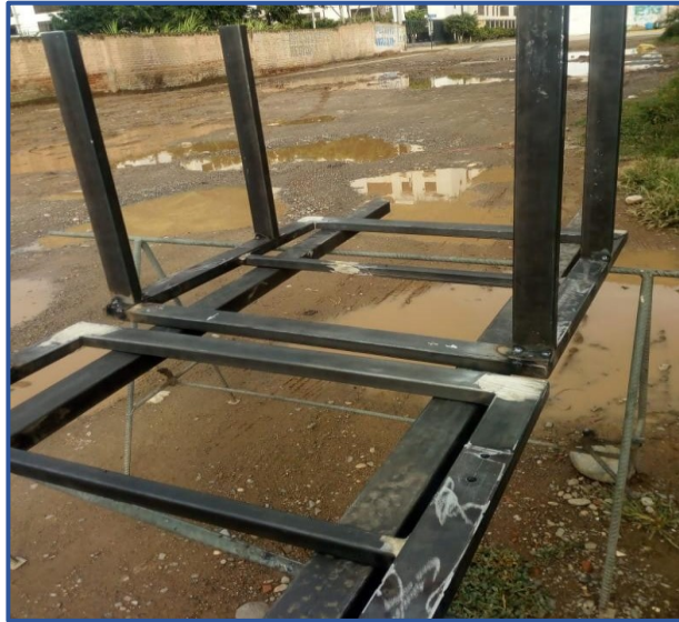
Figura 12 Proceso de armado de la estructura, mediante soldadura eléctrica al arco Fuente: Elaboración propia
