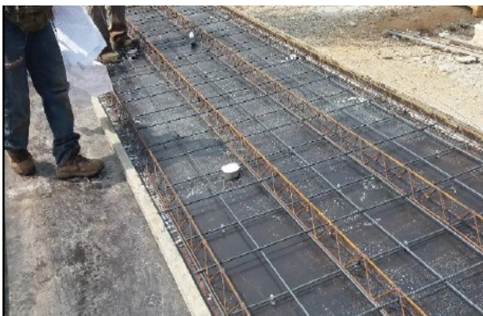
Figura N° 8 Proceso de encofrado
