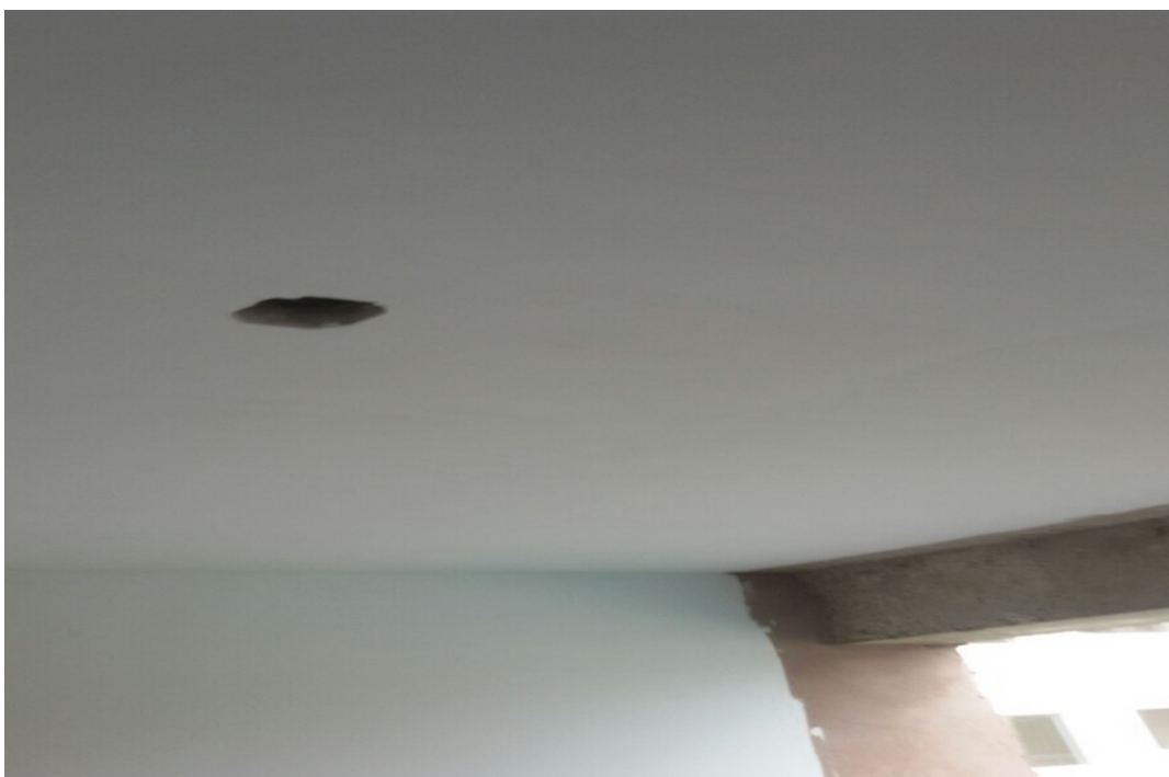
Anexo 13: Acabado de losas.
