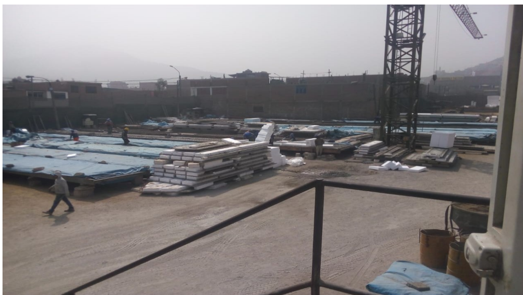
Figura N° 12 Mesas tapadas en la empresa Beton Decken
