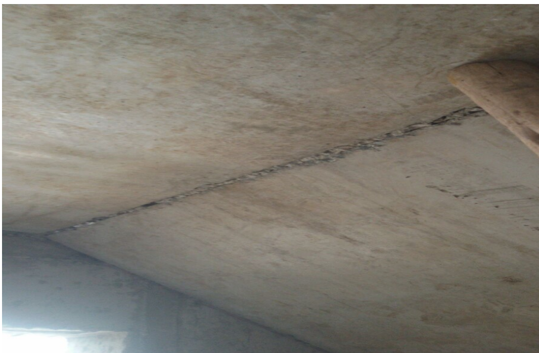
Anexo 12: Vista interior del techo
