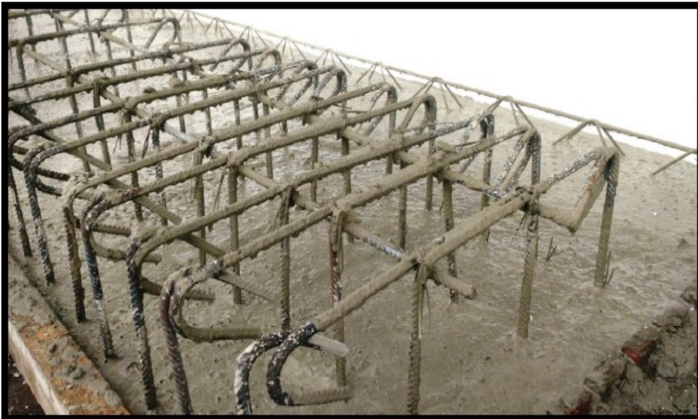
Figura N° 9 Vaciado de mezcla
