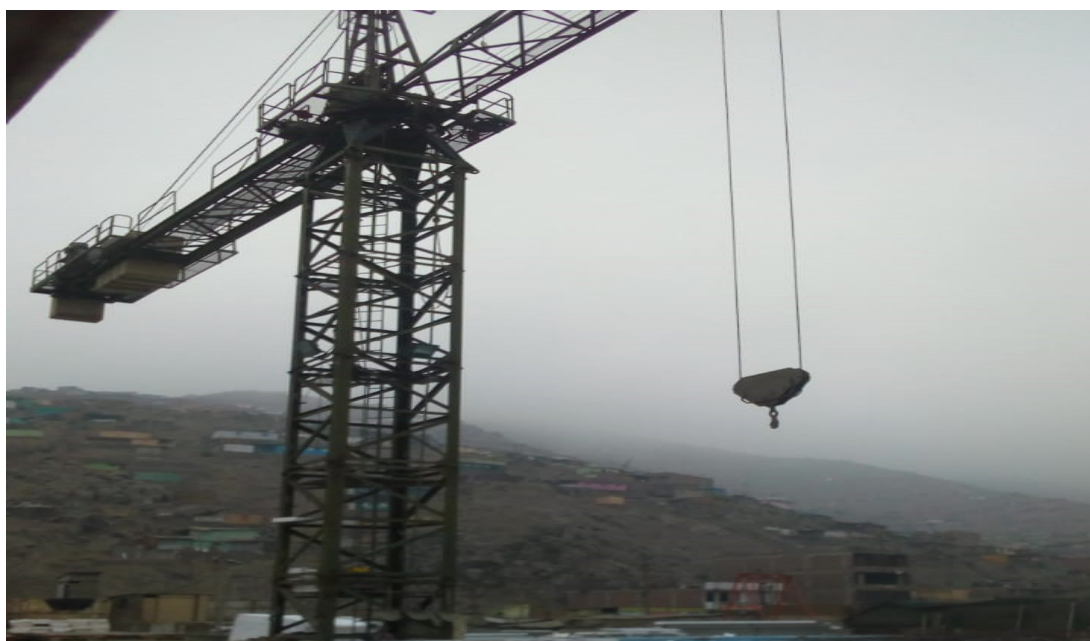
Figura N° 13 Grúa de la Empresa Betondecken
