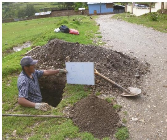
Figura 38. Medición de daño EROSIÓN, G=3. Progresiva: 0+064.82 km.
