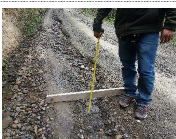
Figura 58. Medición de daño EROSIÓN, G=3. Progresiva: 4+045.95 km.
