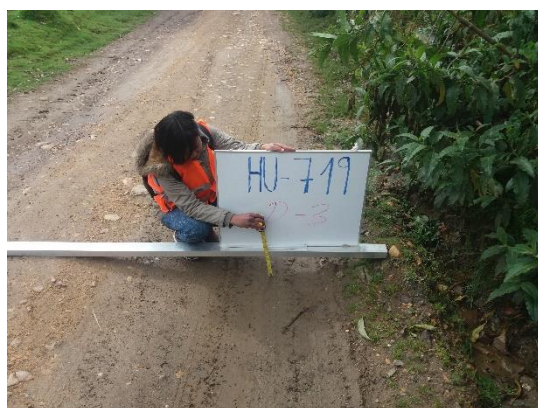
Figura 17. Medición de deformación.
