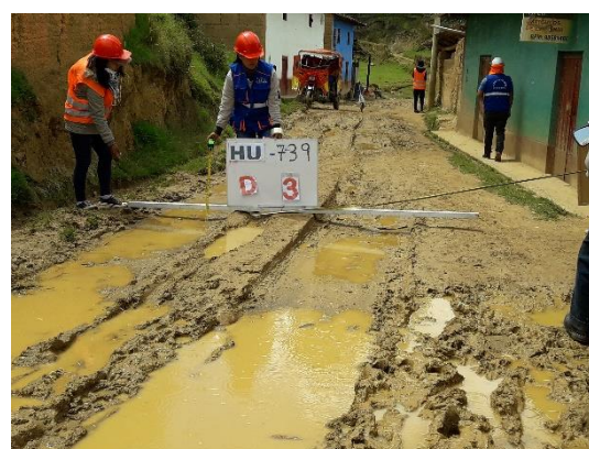
Figura 18. Medición de deformación.
