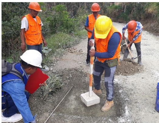
Figura 3. Medición de bache con nivel de gravedad=2.
