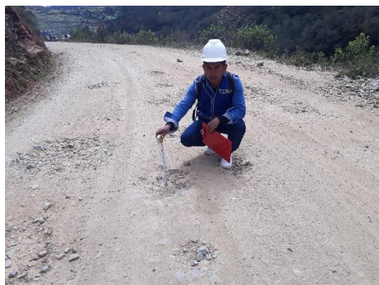
Figura 8. Identificación de bache en region sierra
