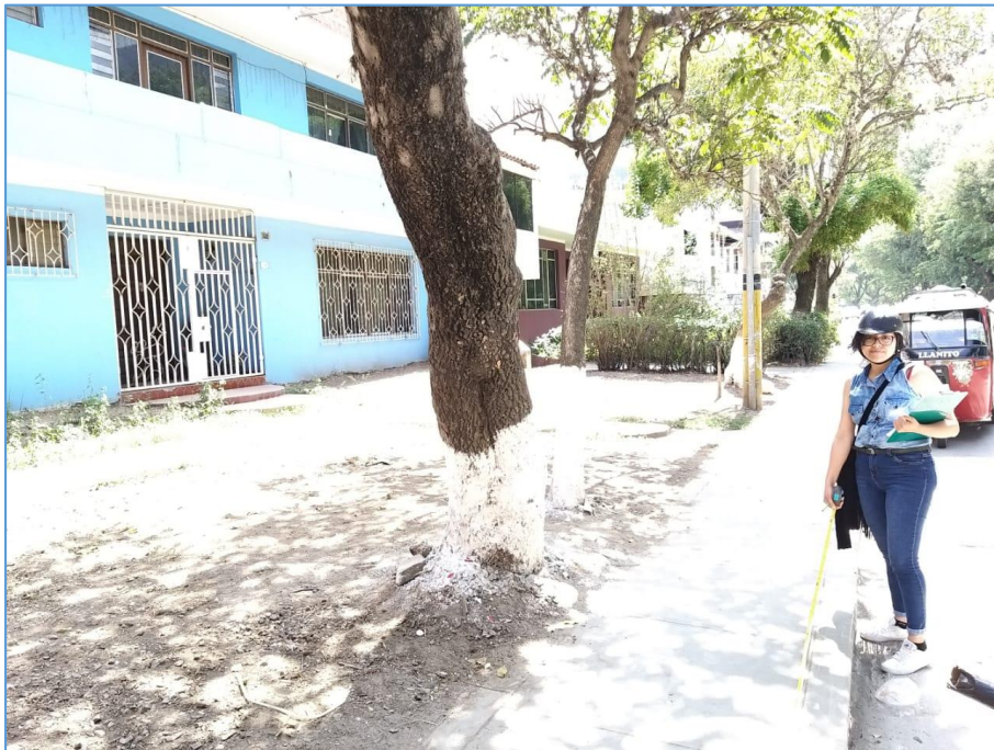
Fotografía N° 4.- Medición de la fachada de la Vivienda unifamiliar ubicada en el Malecón Alomia Robles N°373
