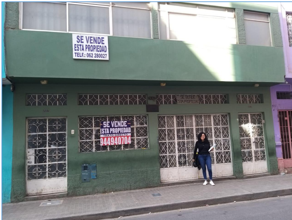
Fotografía N° 8.- Fachada de la Vivienda unifamiliar ubicada en el Jr. Ayacucho N°528.
