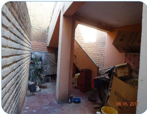
PATIO LAVANDERÍA - PRIMER PISO
