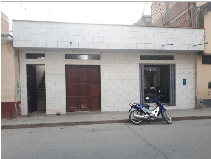
Fotografía N° 5. Fachada de predio ubicada en Jr. Abtao N° 227, vivienda de ubicación residencial media n°1
