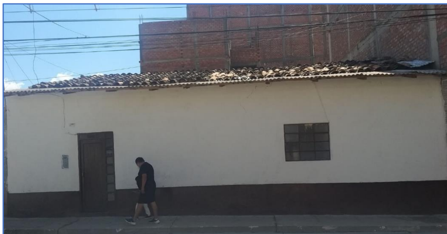
Fotografía N° 6. Fachada de predio ubicada en Jr. Pedro Puelles N° 387, vivienda de ubicación residencial media n°2
