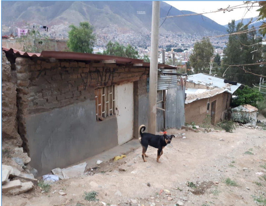
Fotografía N° 11.- Fachada de la Vivienda unifamiliar ubicada en el Jr. Manuel Pardo Aliaga N°109 - AA.HH. La Florida
