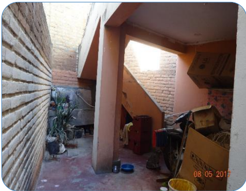
PATIO LAVANDERÍA - PRIMER PISO
