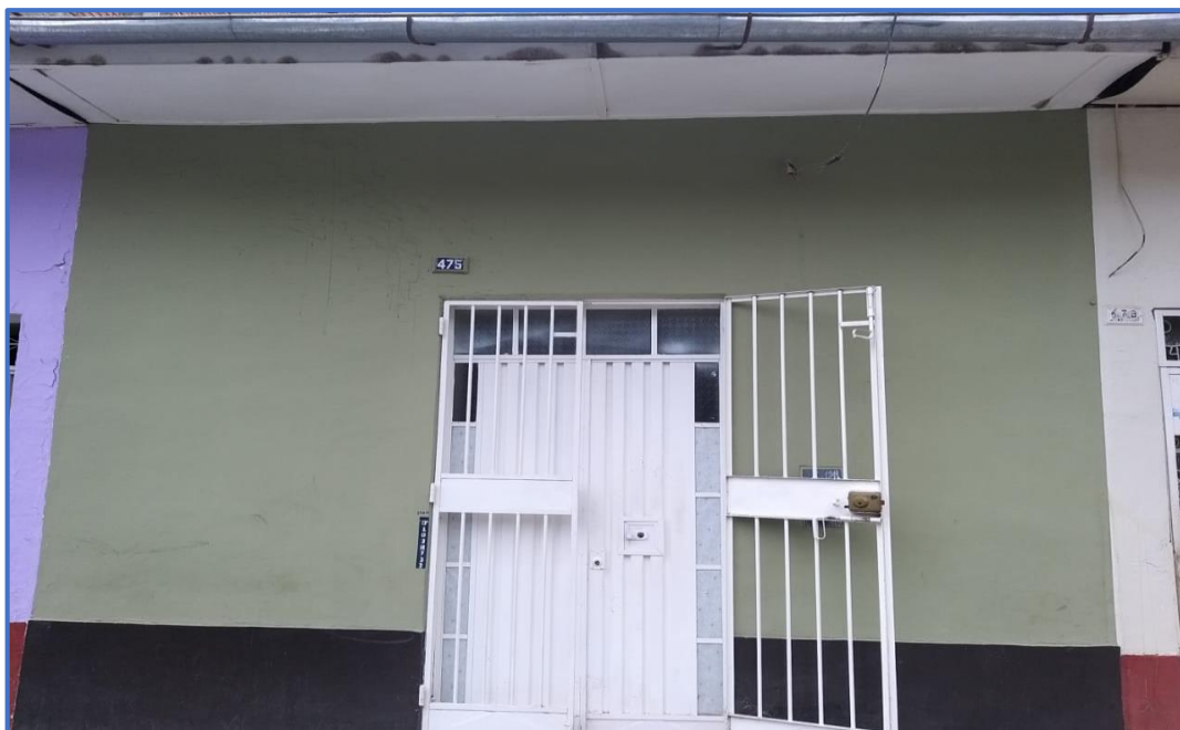
Fotografía N° 7. Fachada de predio ubicada en Jr. Bolívar N° 475, vivienda de ubicación residencial regular n°1.
