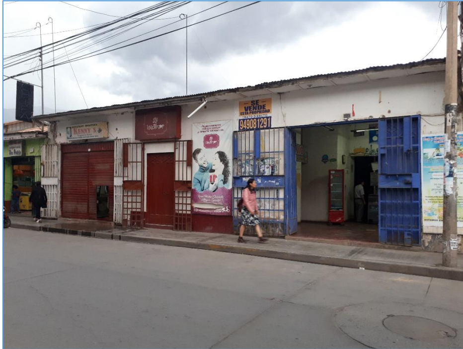
Fotografía N° 9.- Fachada de la Vivienda unifamiliar ubicada en el Jr. Abtao N°933.
