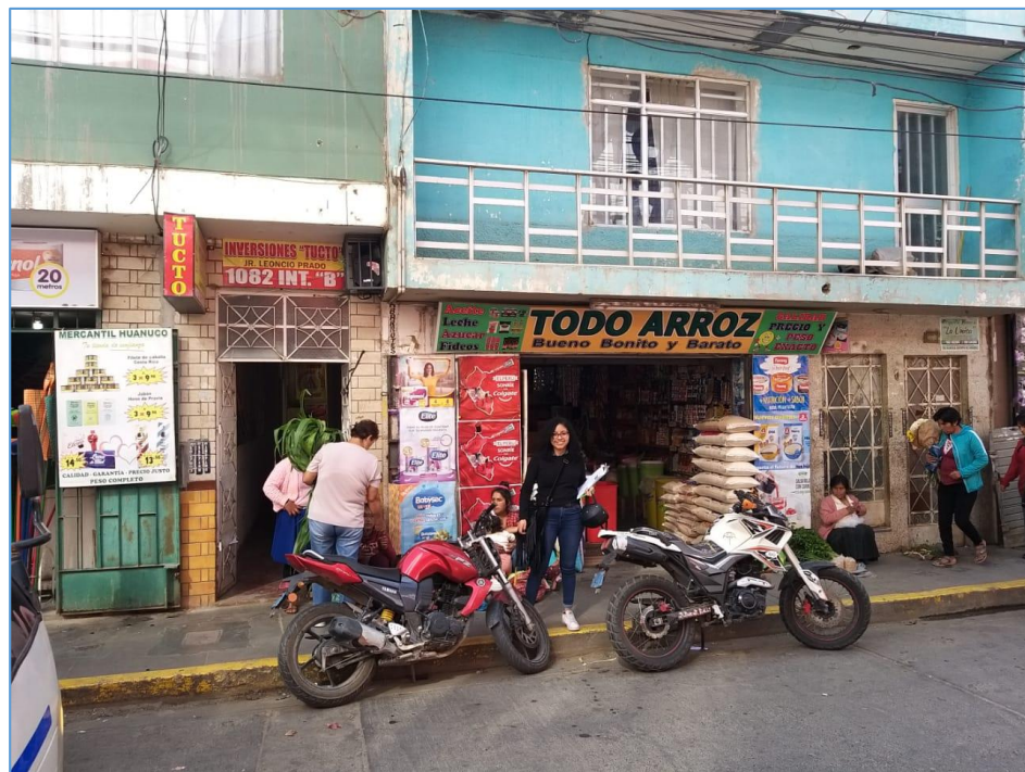
Fotografía N° 14.- Fachada de la Vivienda unifamiliar ubicada en el Jr. Leoncio Prado N°1084.
