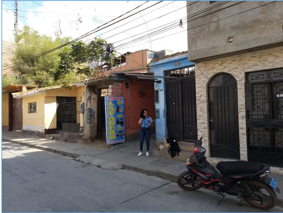
Fotografía N° 5.- Fachada de la Vivienda unifamiliar ubicada en el Jr. Constitución N°255.
