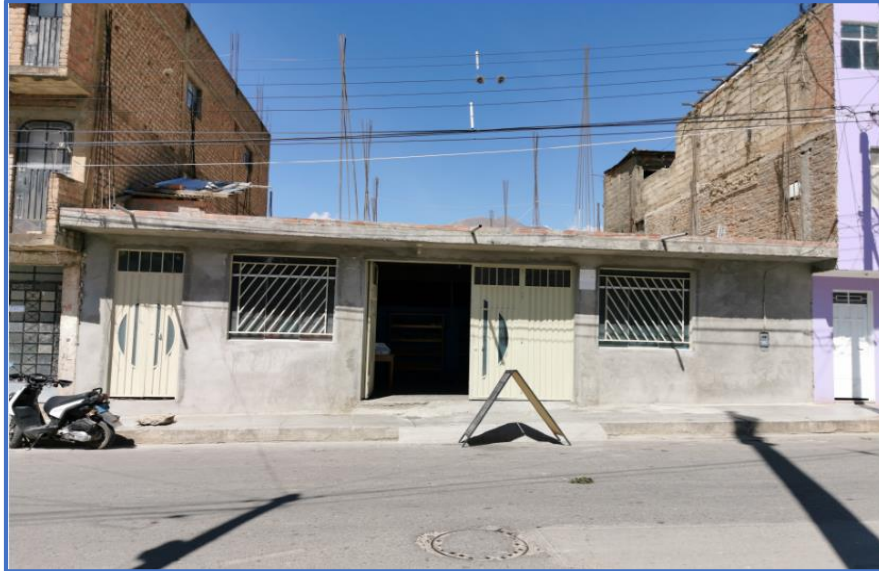
Fotografía N° 8. Fachada de predio ubicada en Jr. Progreso N° 100, vivienda de ubicación residencial regular n°2
