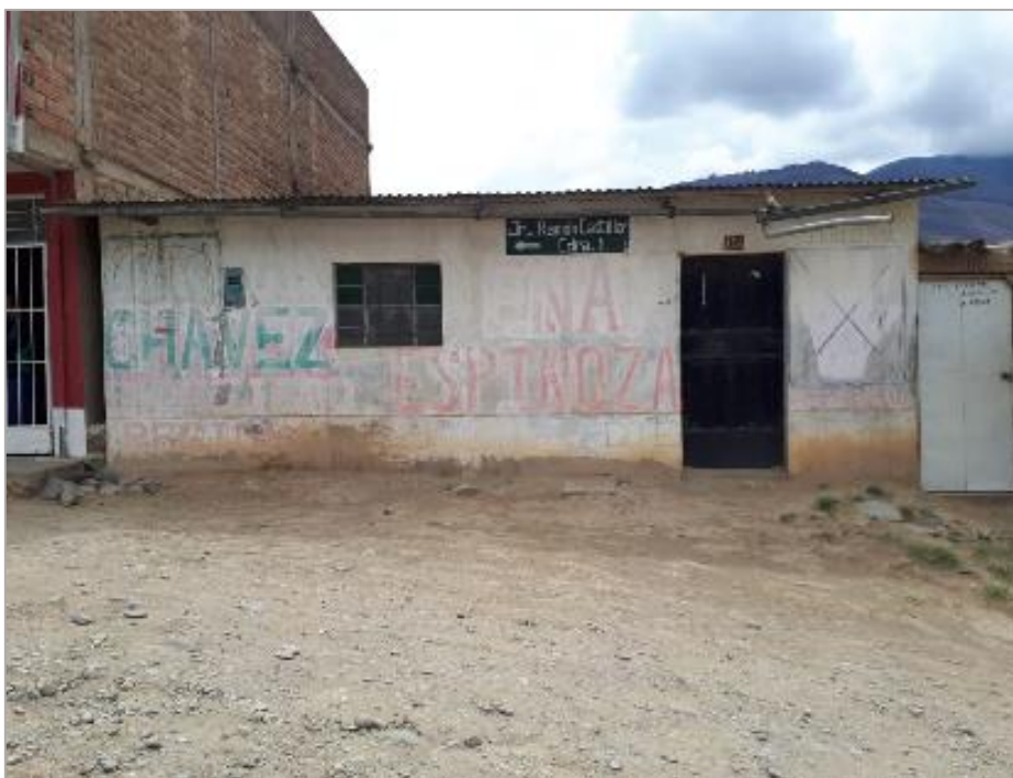
Fotografía N° 11. Fachada de predio ubicada en Jr. Ramón Castilla N° 112, vivienda de ubicación residencial muy baja n°1.
