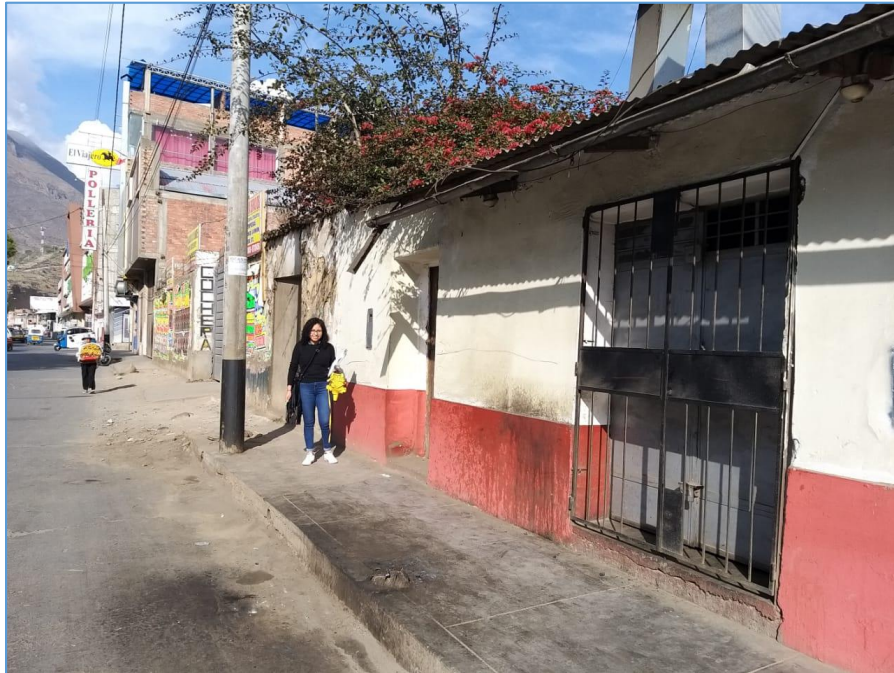
Fotografía N° 1.- Vivienda unifamiliar ubicada en el Jr. 2 de Mayo N° 277.
