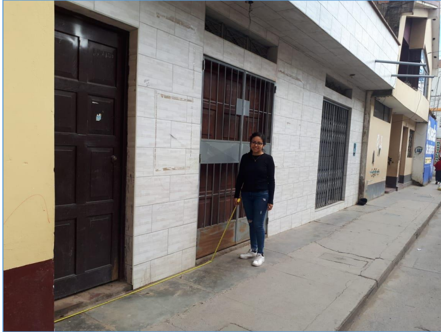
Fotografía N° 15.- Fachada de la Vivienda unifamiliar ubicada en el Jr. Abtao N°227.
