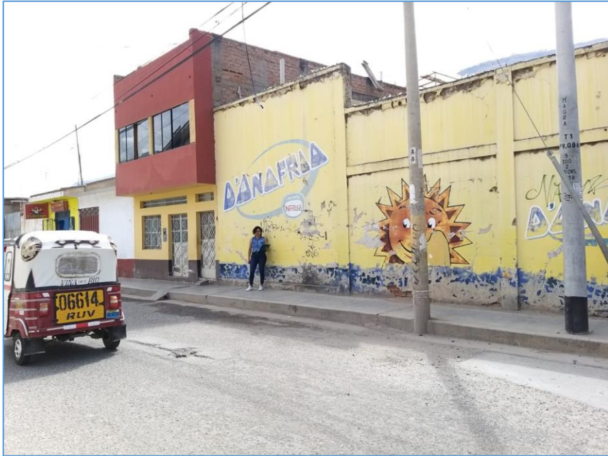
Fotografía N° 17.- Fachada de la Vivienda unifamiliar ubicada en el Jr. Abtao N°1612
