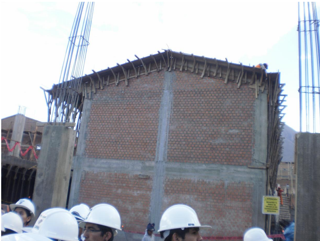
Condiciones del lugar cuyo diseño no toma en cuenta la orientación, respuesta a los vientos, manejo de aguas de lluvias, protección o exposición al sol, aprovechamiento de luz natural, y uso de energías alternativas.
