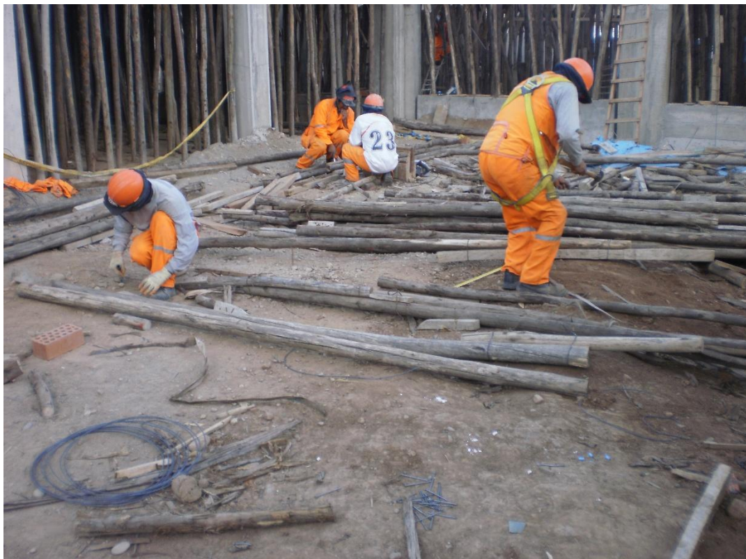
Obsérvese el tradicional sistema de encofrados que genera impacto negativo por la deforestación de árboles y desperdicio de madera en obra. Ecoeficiencia sería el uso de sistemas modernos con puntales telescópicos y formaletas metálicas u otro material reutilizable.
