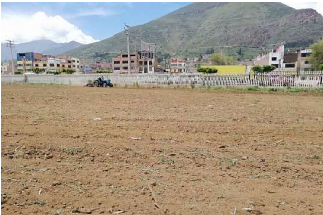
Figura 1: Preparación de terreno.
