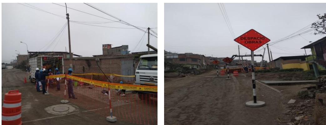
Imagen N° 21. Inspecciones planeadas a la Señalización
