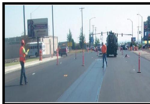
Colocación del Glaspave como refuerzo para la rehabilitación de una vía pavimentada.
