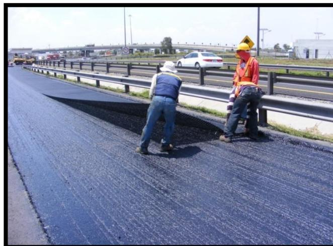
COLOCACIÓN DEL GEOTEXTIL GLASPAVE.
