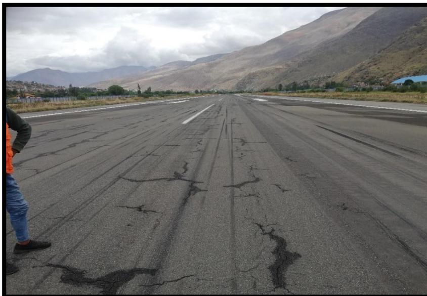
**FOTO 01: EVALUACIÓN VISUAL DE CAMPO SE APRECIA LA APARICIÓN DE FISURAS EN EL PAVIMENTO, ASÍ COMO EL AHUELLAMIENTO.**
