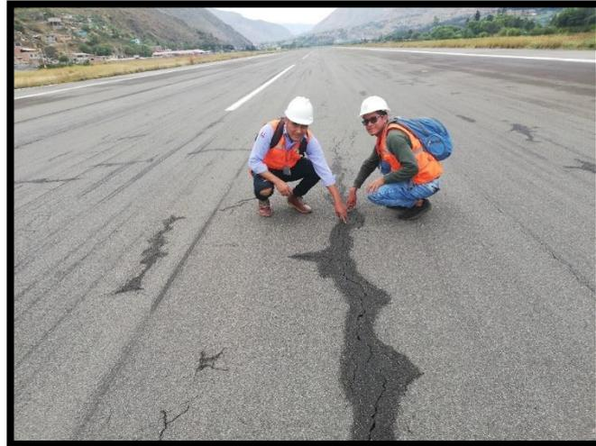
**FOTO 02: FISURAS MÁS PRONUNCIADAS SE APRECIA EL INGRESO DE LA GUA POR DICHAS GRIETAS.**
