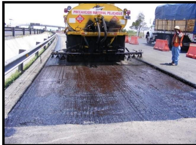
PROCEDIMIENTO DE COLOCACIÓN DE UN RIEGO DE LIGA.
