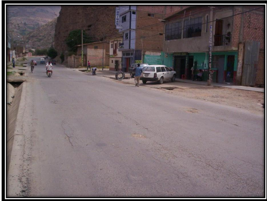
**Foto No 2** Fisuras más pronunciadas se aprecia el ingreso de la gua por dichas grietas
