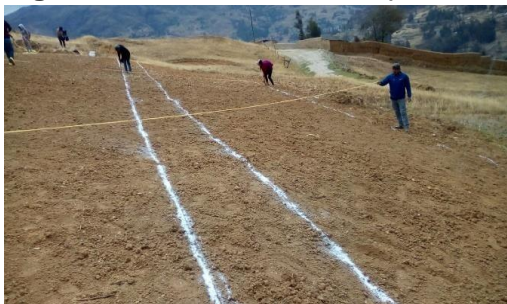
Fig. N° 03: medición de bloques
