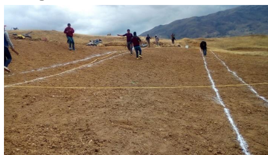
Fig. N° 04: nivelación de terreno
