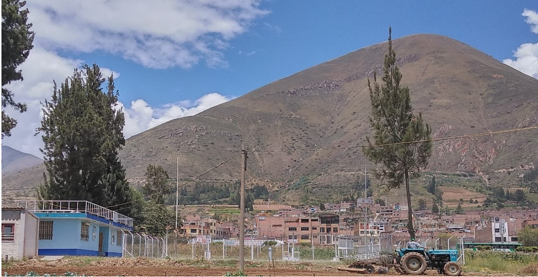
Figura 01. Preparación de terreno.
