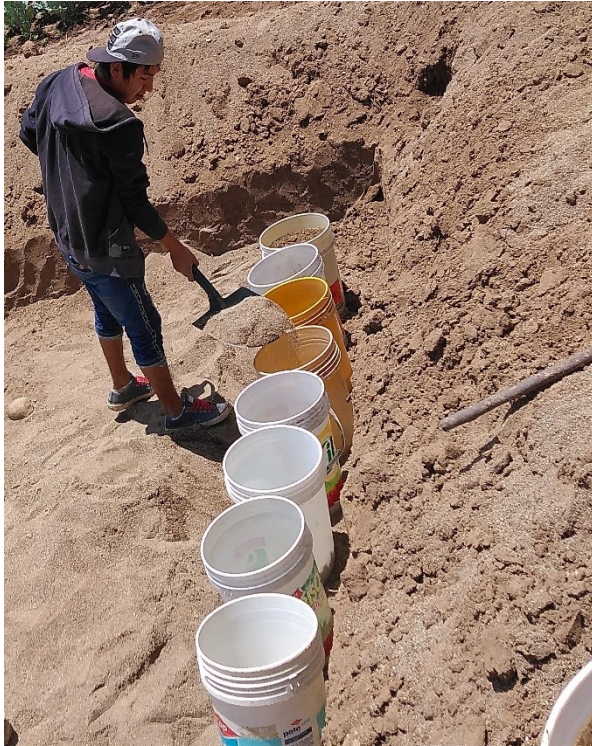
Figura 03. Llenado de grava, arena y tierra.
