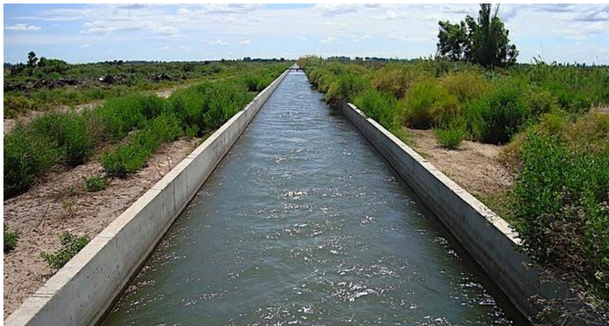
Canal de aducción
