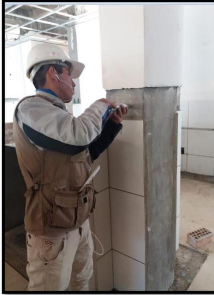
*Fotografía N° 17. Prueba de esclerómetro columna del módulo III.*
