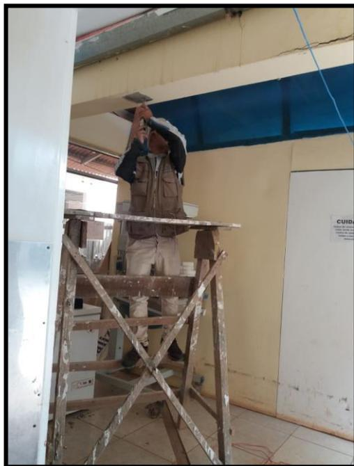
*Fotografía N° 23. Prueba de esclerómetro en la columna del módulo antiguo.*
