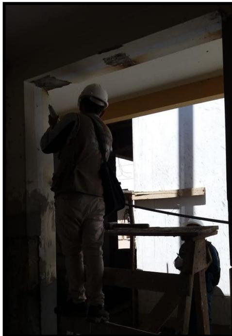
*Fotografía N° 22. Prueba de esclerómetro en la viga del módulo antiguo.*
