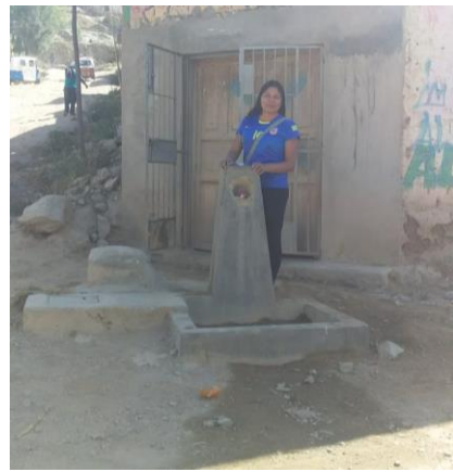
Fotografía N° 2- en este fotografia se muestra una de las 5 piletas públicas para recojo de agua en sector 01 - Moraspampa
