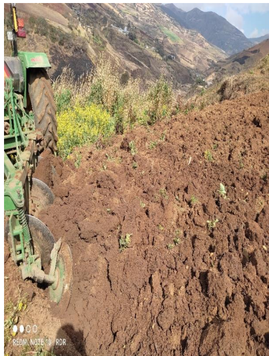
Fig. 14 preparación del terreno con tracción mecánica
