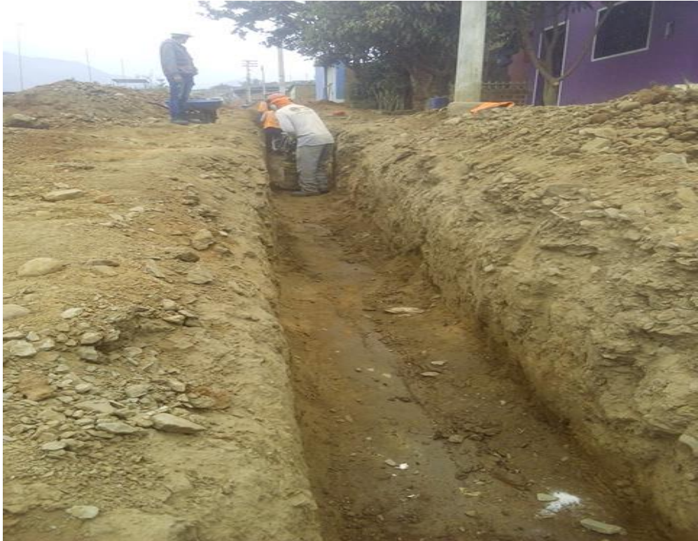
Compactado de zanjas.
