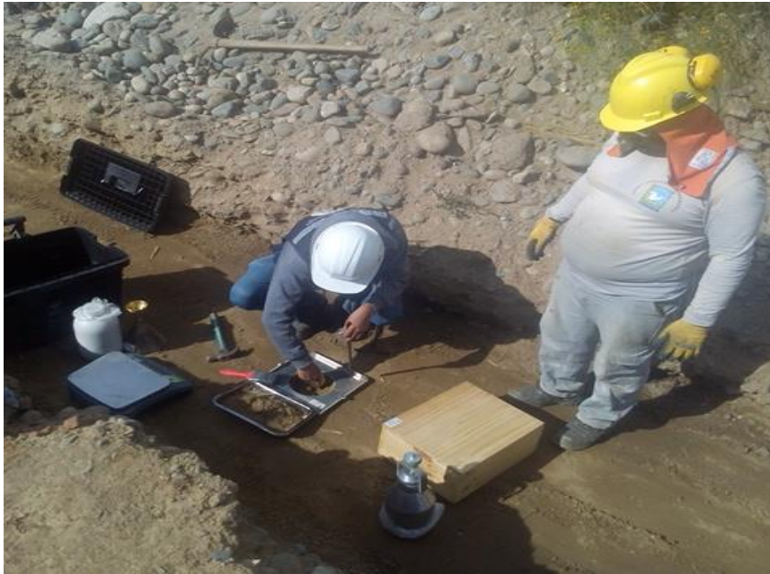
Realizando el ensayo de densidad de campo por el método de cono de arena.
