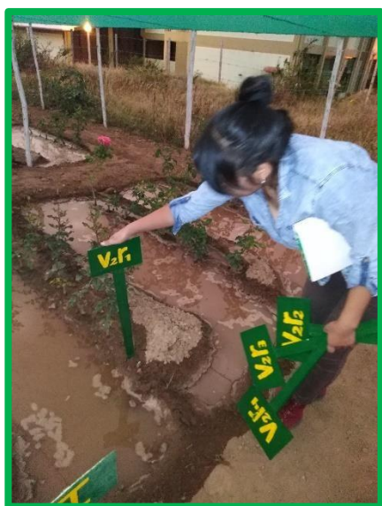
Fig. N°39: Instalación de letreros.
