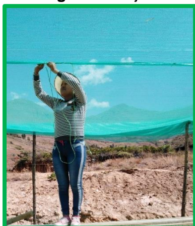
Fig. N°33: Instalación de cobertor.
