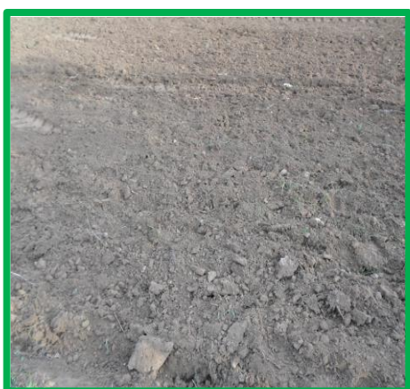
Fig. N°05: Preparación de terreno.
