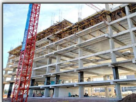
ENTRE PISOS DE LOSA ALIGERADA
