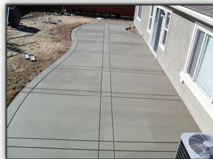
PISO DE CEMENTO FROTACHADO Y BRUÑADO EN
