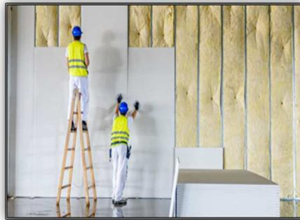
USO DE MUROS CON EL SISTEMA DRYWALL
