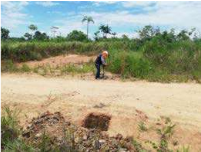
Fotografía 2. – la perforación de calicatas en los lados derecho e izquierdo de la vía UC-583.
