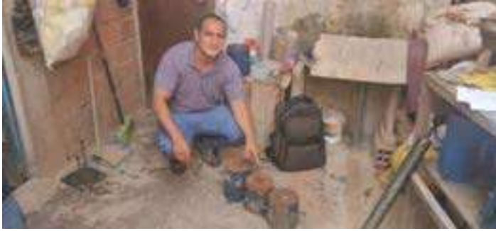
Fotografía 45. – presentación de los tres moldes posterior a la penetración para una sola calicata.
