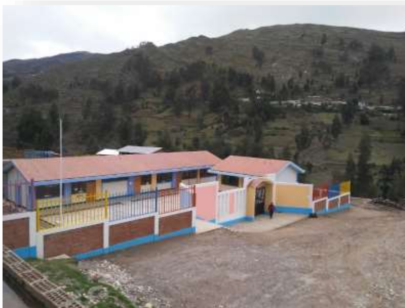
Foto N° 01: Institución Educativa N° 302 de Colquillas donde se aplicó la investigación.
