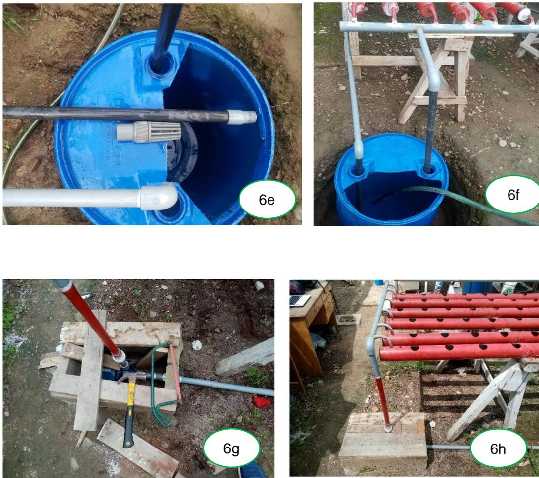
**Figura 6: Instalación de los tubos (6a). Pintado de tubos (6b-6c) ,nivelación de tubos con agua (6d),instalación de la válvula de pie (6e), llenado de agua en el cilindro (6f),instalación de la bomba de agua y conexión eléctrica y instalación terminada del sistema hidropónico NFT (6h)**
