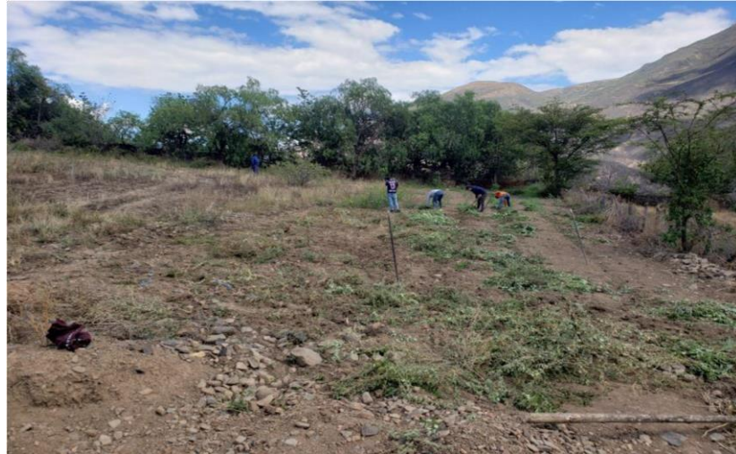
Figura 4. Limpieza del terreno
