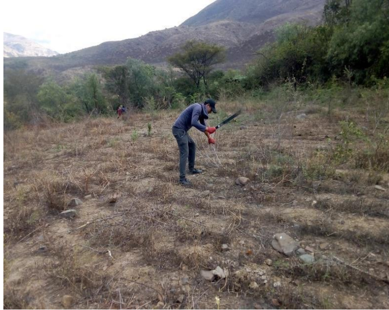
Imagen 01. Preparación del terreno
