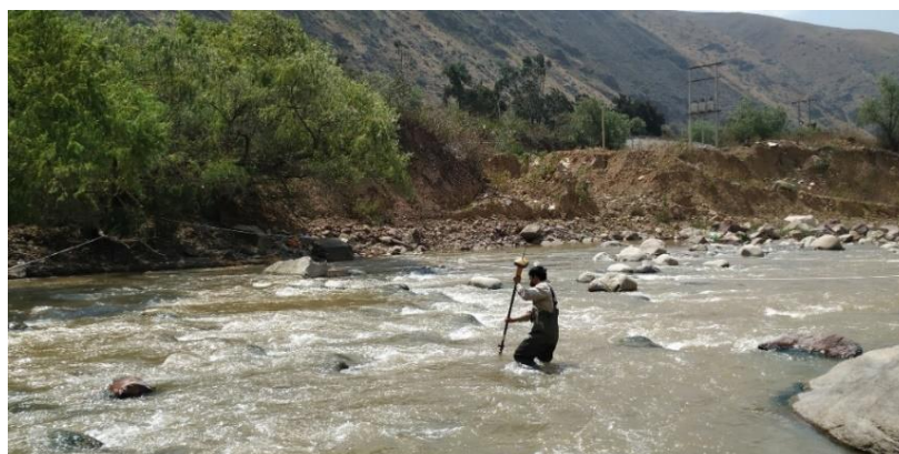
Levantamiento topográfico de las trampas de carga de fondo
