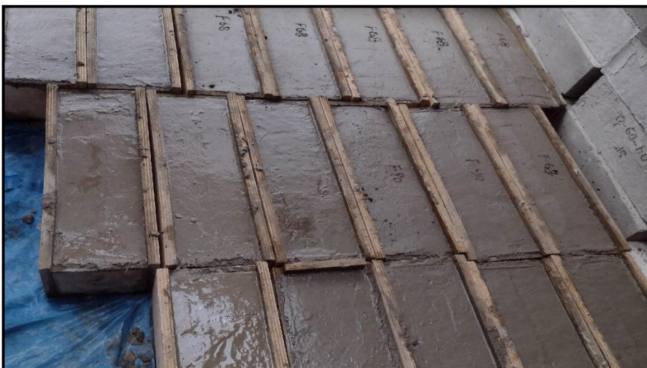
Figura 24 Elaboración de las viguetas.
