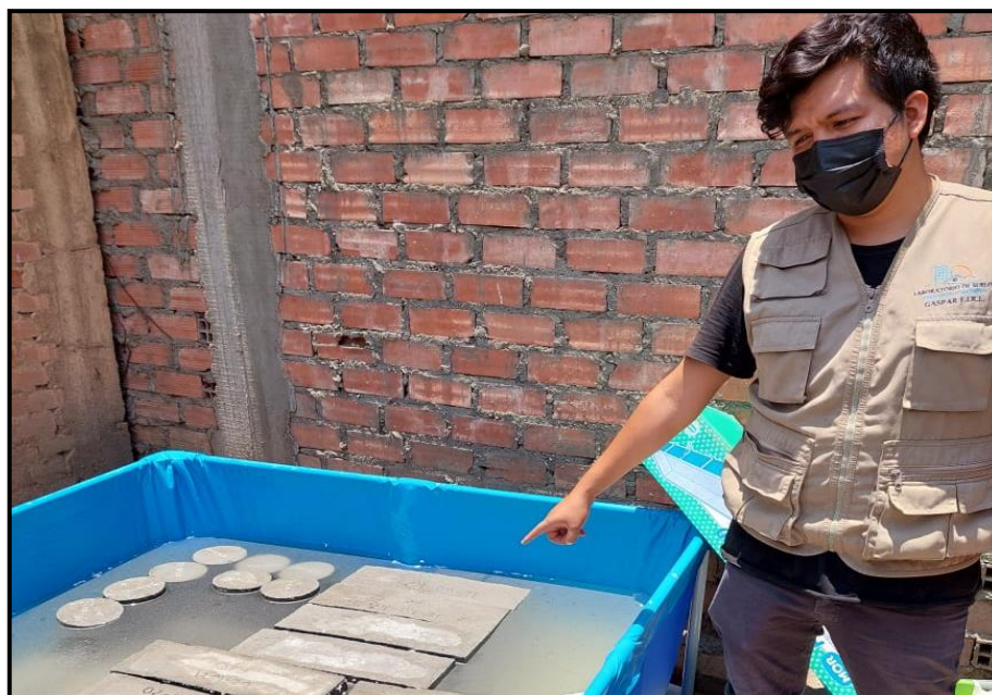
Figura 26 Curado de las viguetas.
