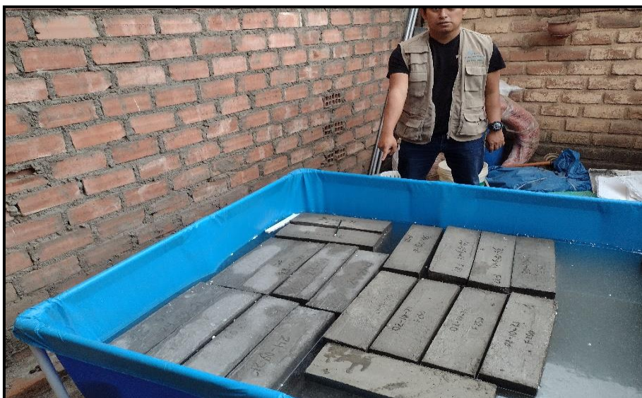
Figura 25 Curado de las viguetas.
