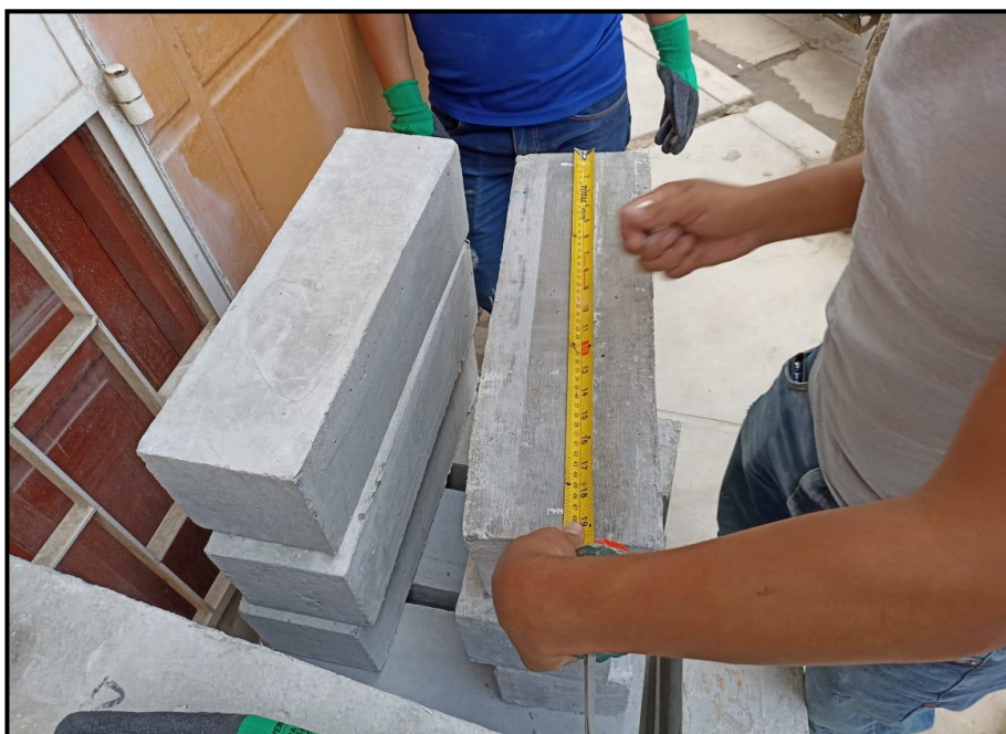
Figura 30 Preparación de la marca a un tercio de las vigas.
