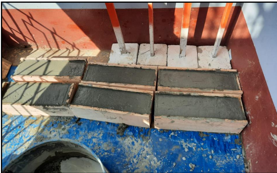
Figura 23 Elaboración de las viguetas.
