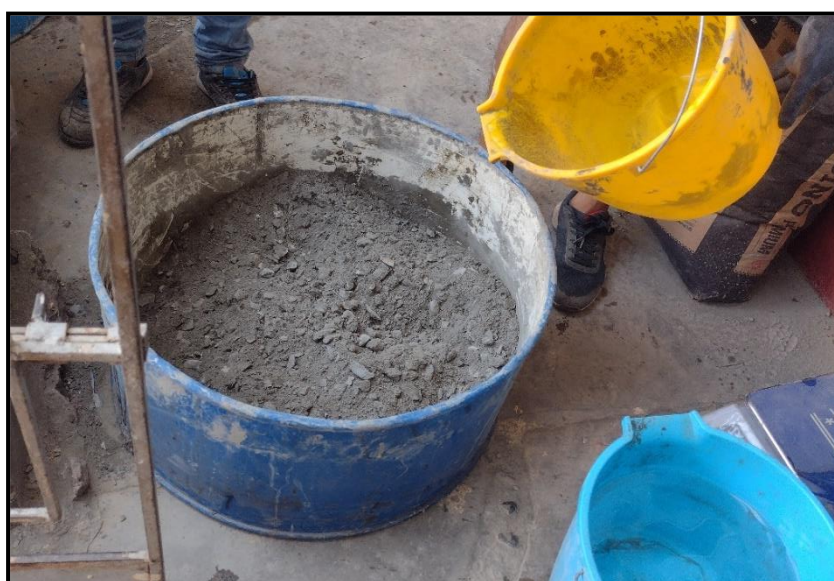
Figura 21 Materiales para la elaboración de la mezcla
