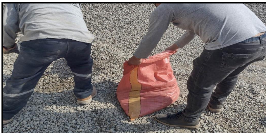
Figura 10 Acopio de agregado grueso y de piedra chanchada
