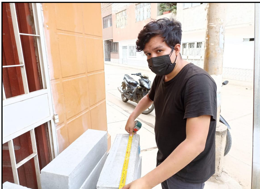
Figura 29 Preparación de la marca a un tercio de las vigas.
