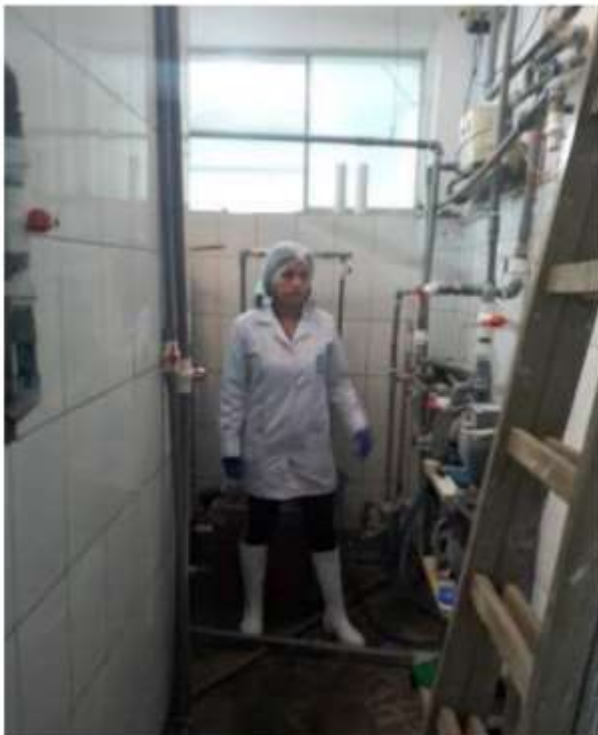
g) Inspección de los filtros y válvulas
