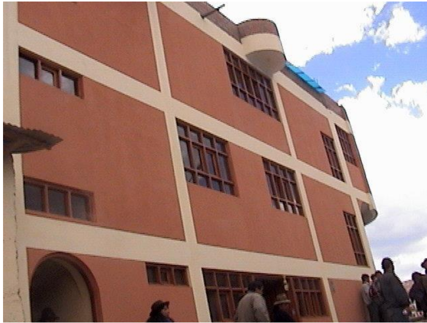
Comedor universitario construido con recursos de la Municipalidad Provincial de Yarowilca
