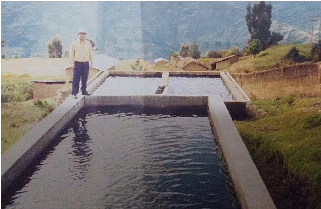
Inspección del reservorio de agua que consume la población de Obas
